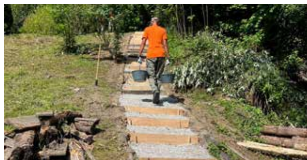
Unterstützung WK / Erneuerung Treppe
