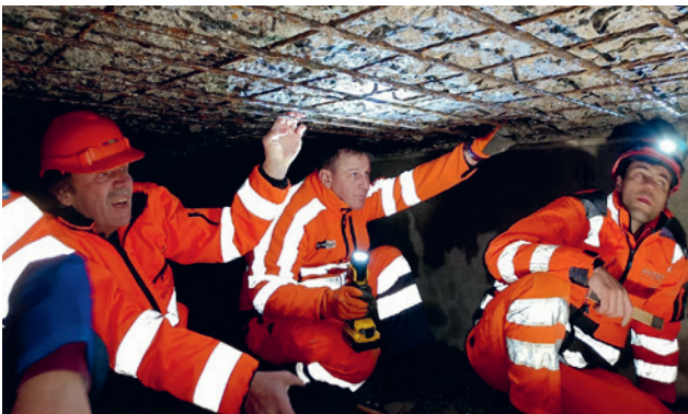
Kontrolle der verstärkten Armierung im Entlastungskanal
