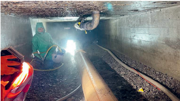
Arbeiten unter erschwerten Bedingungen im Entlastungskanal
