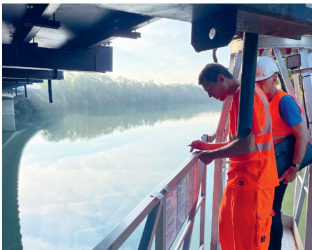
Kontrolle Brückenuntersicht
