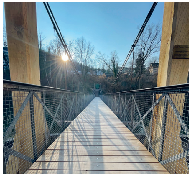
Instandsetzung der Paul-Fischer-Brücke (Gwagglibrugg)
