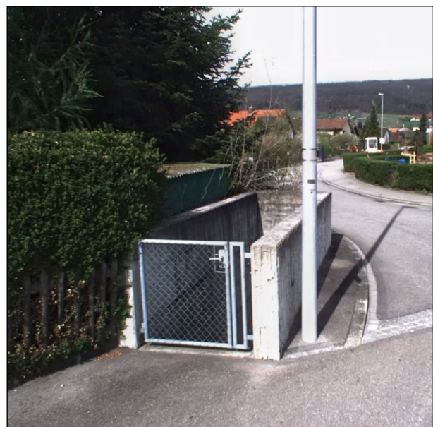
Foto: Pumpwerk Bernau (Bernaustrasse)
