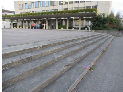
4.42 grosszügige Treppenanlage zur Zentralstrasse
