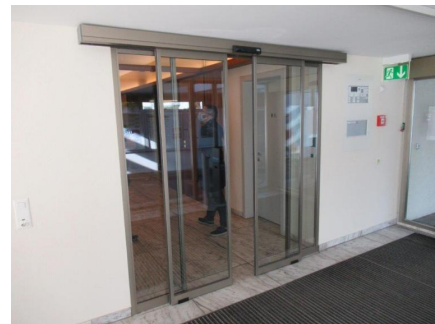
4.10 automatische Schiebetür Seiteneingang EG
