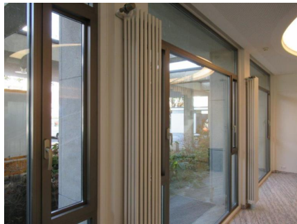
4.15 neue Heizkörper mit Thermostatventilen im EG
