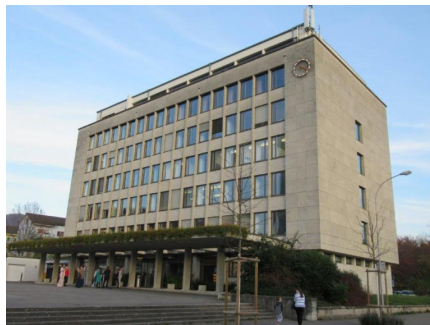
4.4 Northwest- und Südwestfassade
