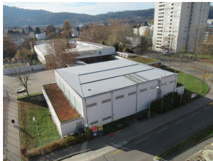
4.3 Rathausbedachung wie Nachbargebäude (Foto)
