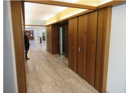
4.33 Natursteinbodenbelag im EG
