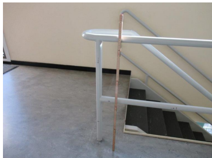
4.37 Treppengeländer 6.OG durchkriech- und bekletterbar
