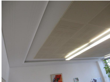
4.34 Akustikdecke im EG
