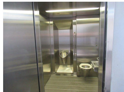
4.29 neues öffentliches WC im Nebengebäude
