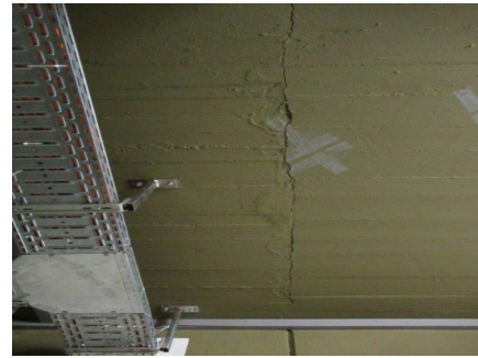
4.2 größerer Deckenriss im UG
