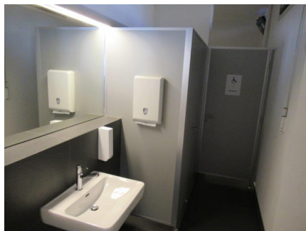
4.28 neue Toilettenanlage im EG
