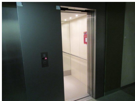
4.25 Liftkabine mit Wandverkleidung
