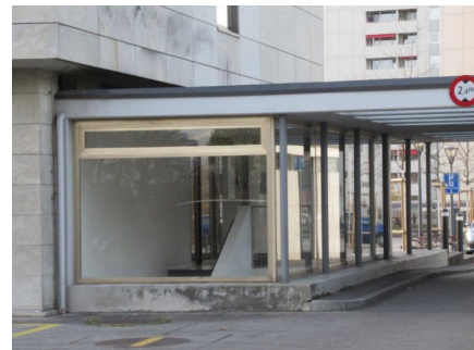
4.12 Seiteneingang Originalverglasung
