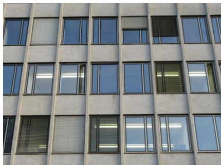
4.13 Lamellenstoren Hauptfassade
