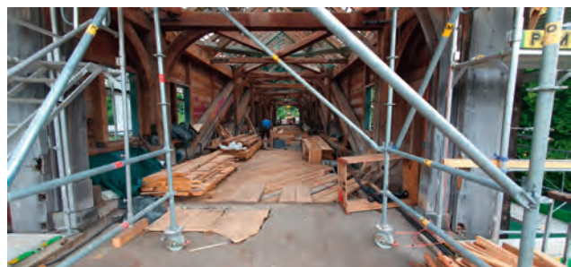
Sanierung der Holzbrücke
