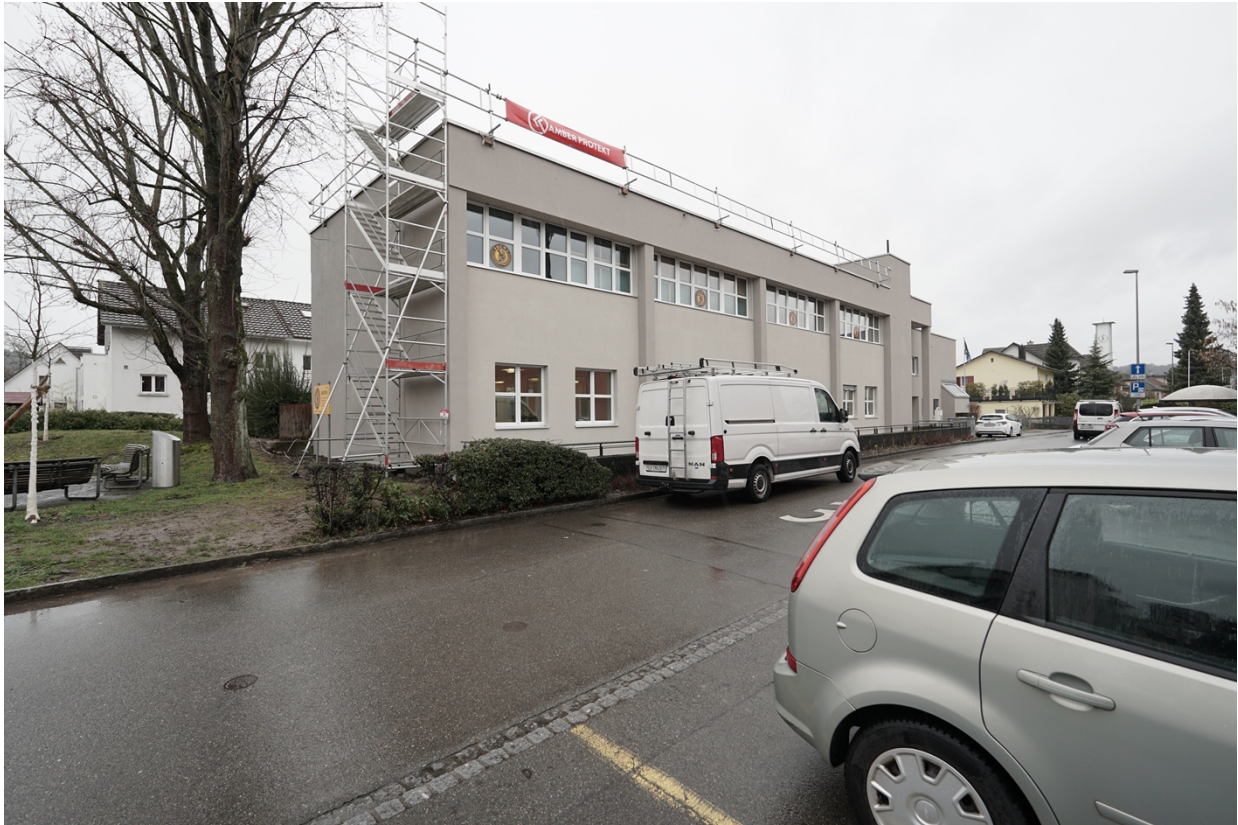
Abbildung 3, Februar 2024 Fertigstellung und Montage Phovoltaik-Anlage durch Energie Wettingen AG
