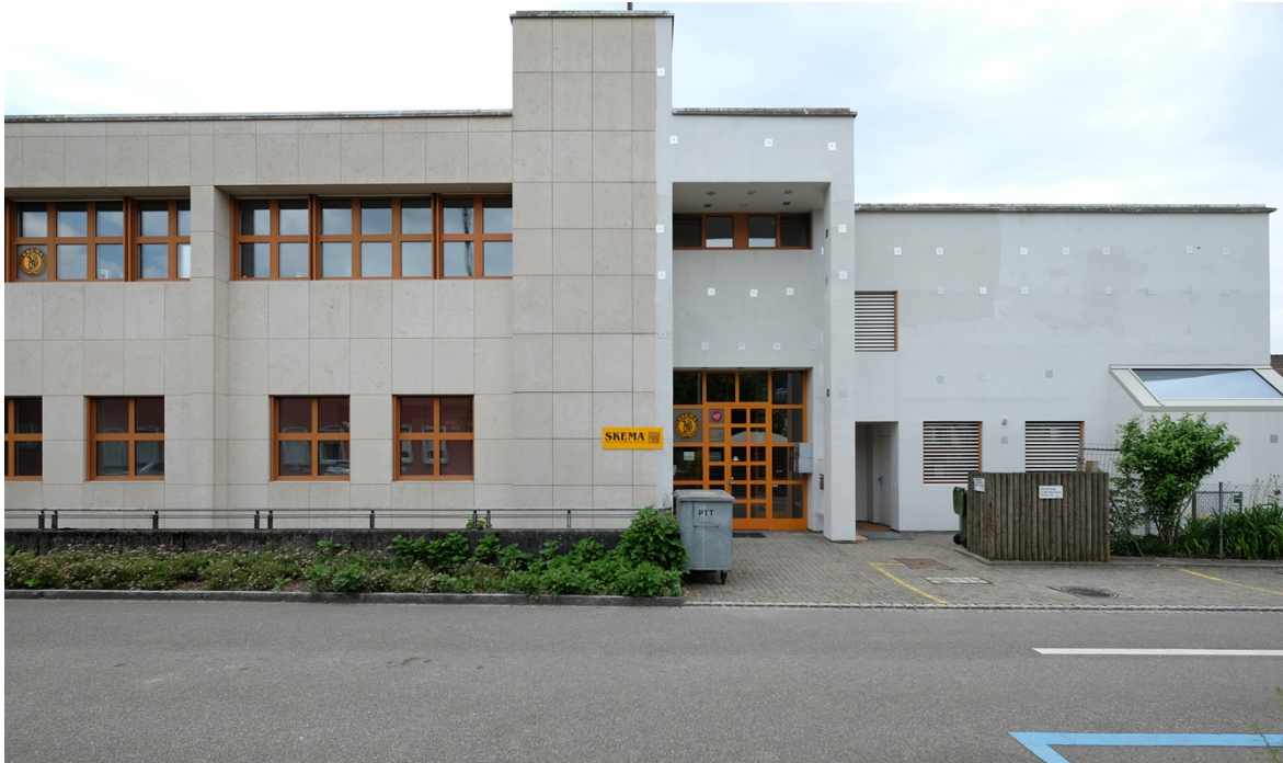
Abbildung 1, Juni 2022 Sicherung Fassade
