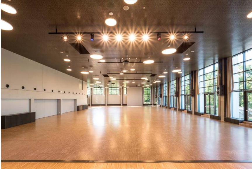
Abbildung 5: Saal mit Erdbebenertüchtigung im Hintergrund
