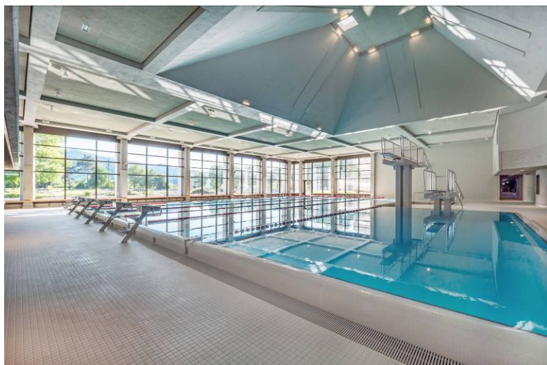
Abbildung 2: Das frisch sanierte Hallenbad ist heller und freundlicher
