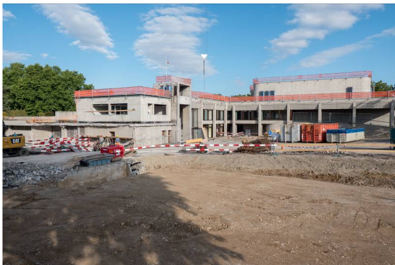
Abbildung 14: Rohbau zu Beginn der Baustelle
