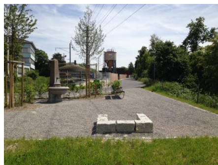
Bild 2: Neu erstellter Verweil- und Rastplatz
