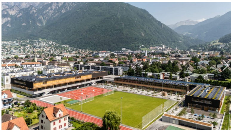
Abbildung 14 Schul- & Sportanlage Fortuna Luftbild
