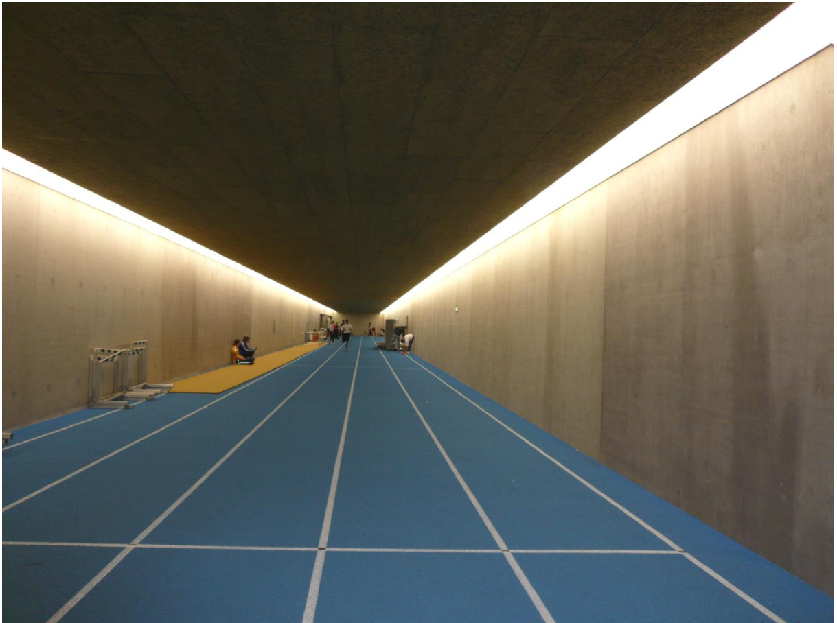
Typenbild; Indoorsprintanlage Letzigrund Zürich
