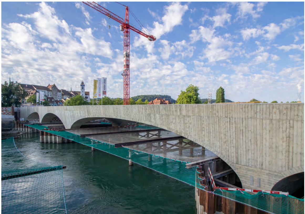
Die neue Kettenbrücke wird zum attraktiven Aarauer Wahrzeichen.
