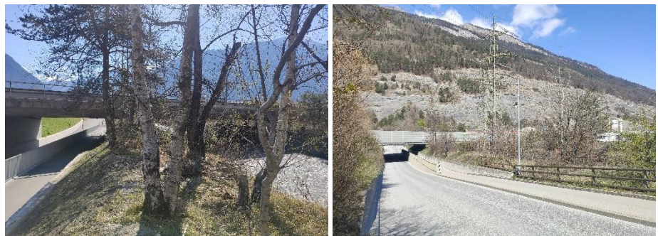
Fotos: Autobahnunterführung Untere Plessurstrasse / Autobahnunterführung Felsenaustrasse
