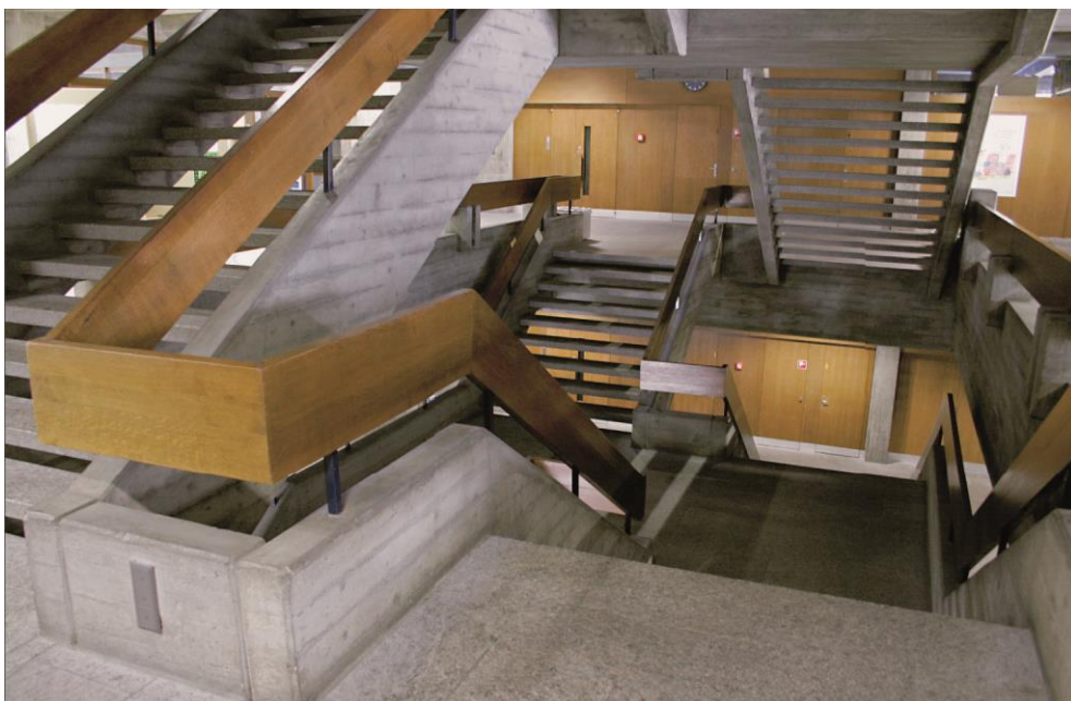
Treppenhaus der GBC
