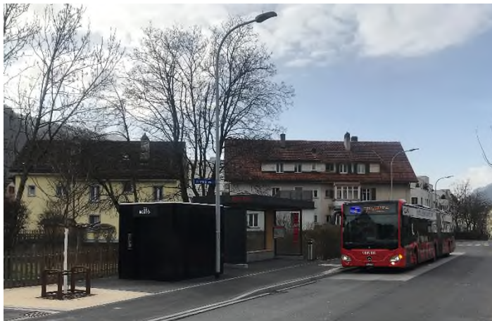
Neuer Personenunterstand Bus und öffentliches behindertengerechtes WC
