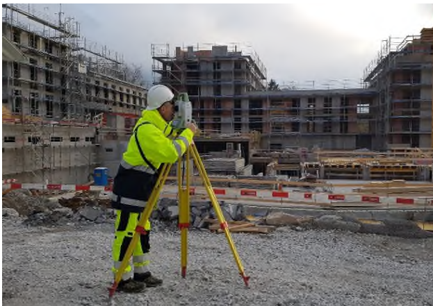
Bauvermessung, Überbauung Hof Masans
