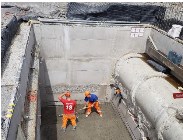
Rohbau Pumpwerk Gürtelstrasse
