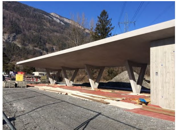
Oberbau Regenbecken mit Stützen für neue Veloabstellanlage
