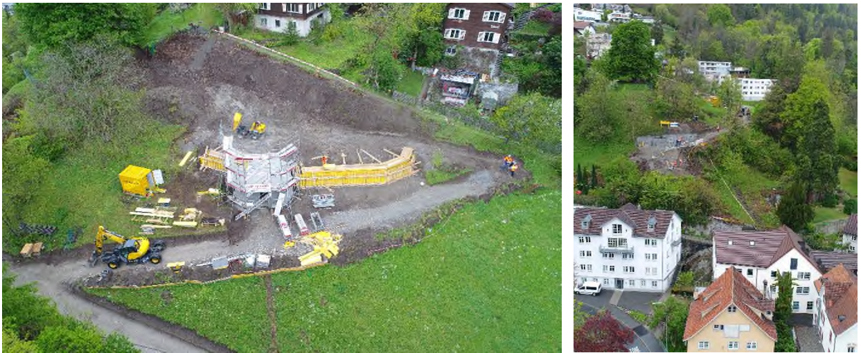
Luftbild der Bauarbeiten Gabentempel, Frühling 2019 _ Luftaufnahme, Bauarbeiten Treppenaufgang, Frühling 2019
