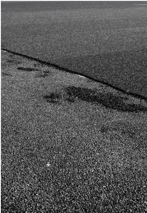
Sickerasphaltschicht mit Elastiktragschicht
