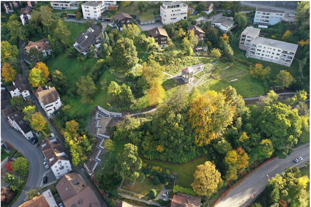
Luftaufnahme mit fertiggestelltem Treppenaufgang und Gabentempel, Herbst 2019
