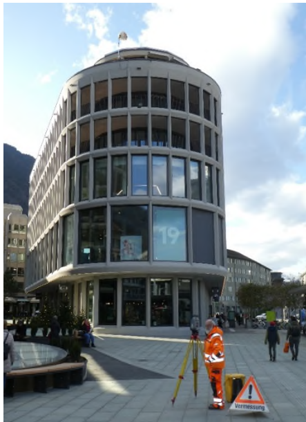
Aufnahmen NF AV Neubau Steinbock
