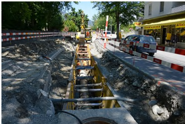
Kanalisationsaushub mit Grabenspriessung
