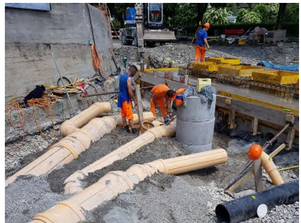
Pumpendruckleitungen Abwasserpumpwerk
