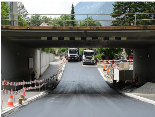
Einbau Tragschicht
