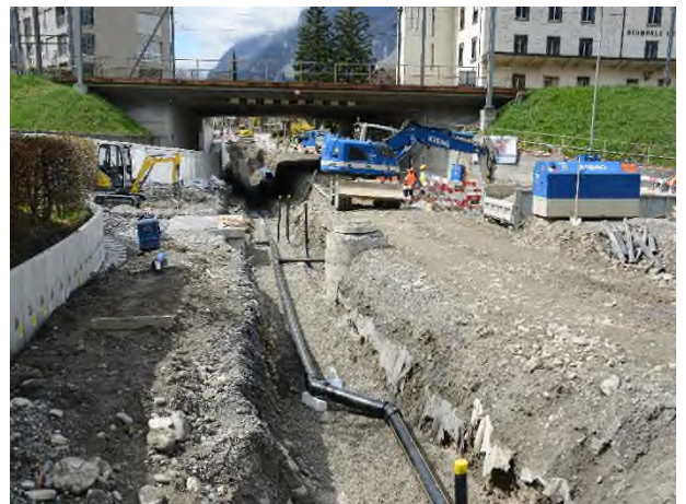
Einlegen Werkleitungen
