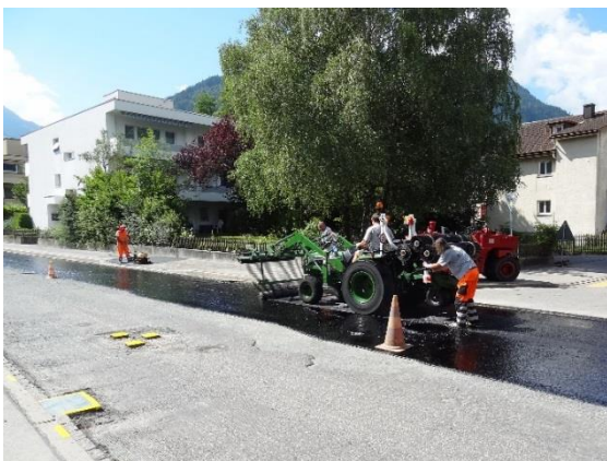
Einbau Deckbelag "Vorbrausung"
