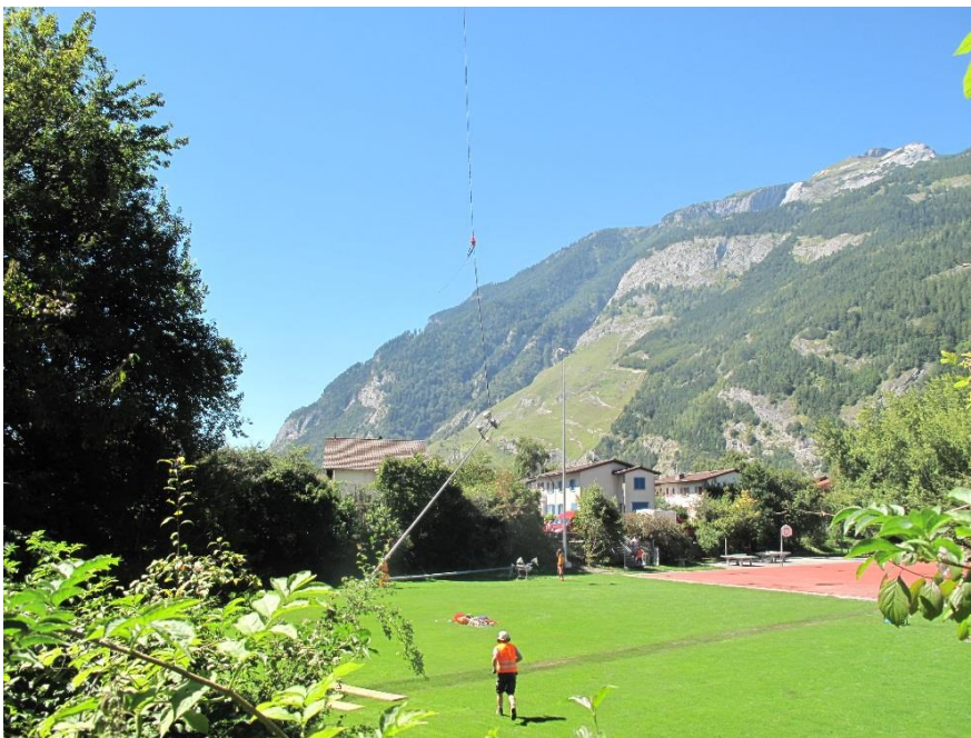
Die alten Kandelaber mussten teilweise auch mit Helikopter entfernt werden
