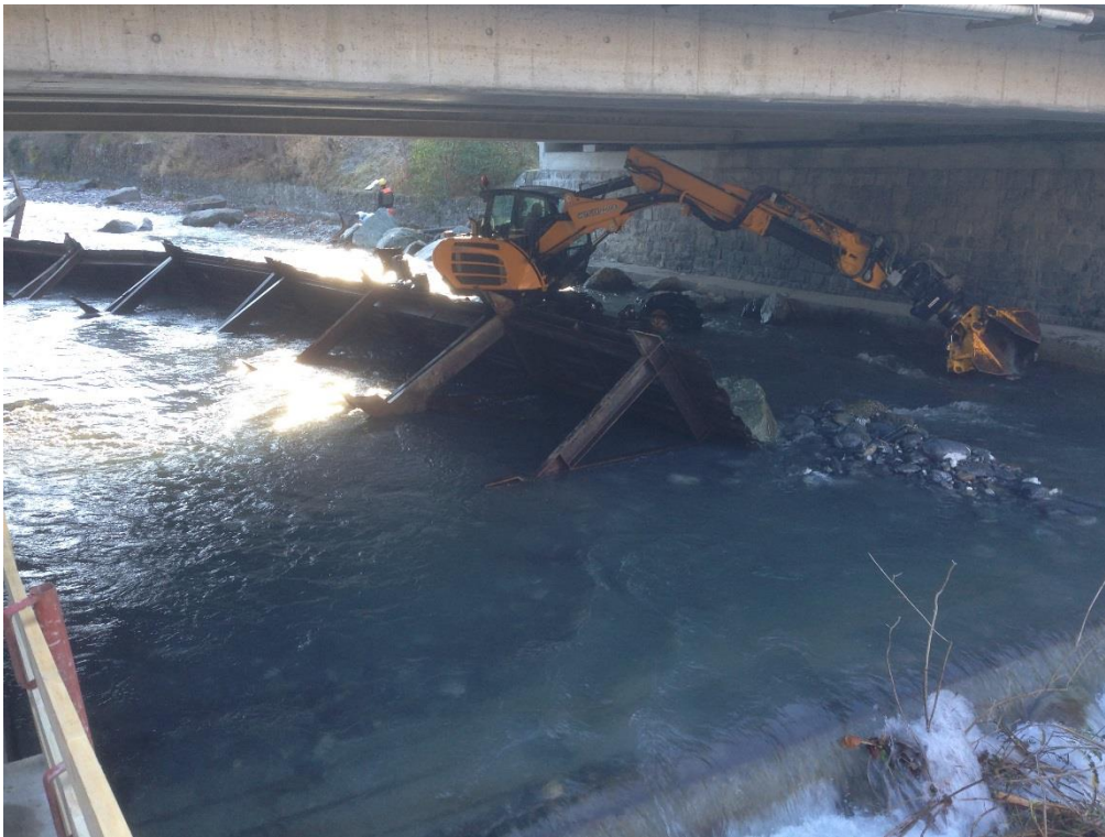
Wasserhaltung für die Sanierungsarbeiten
