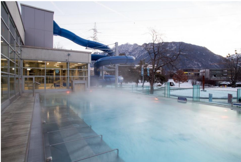
Sicht vom Aquamarin auf die neue Rutschbahn
