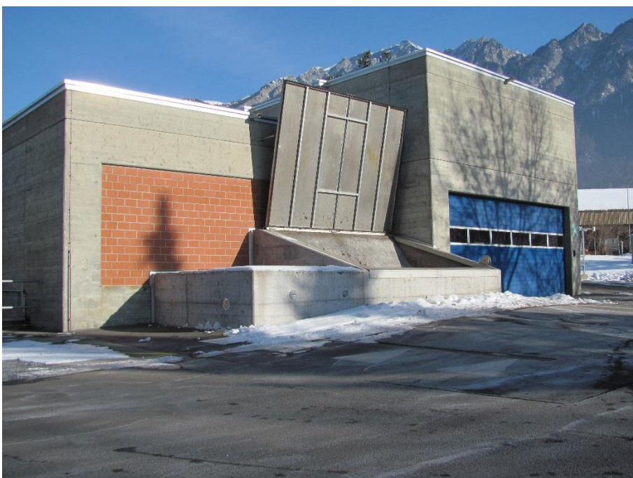
Die neu erstellte Fremdsandannahmestelle
