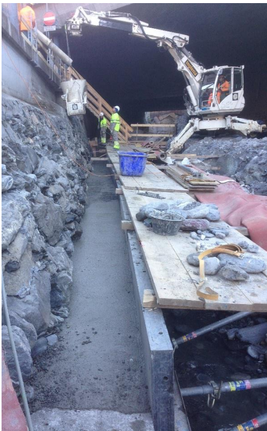
Neuer verstärkter Wuhrfundamentfuss
