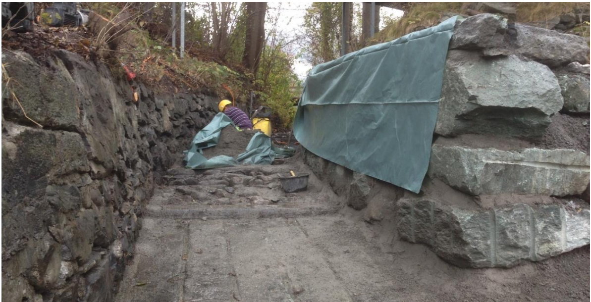
Auslaufbauwerk mit neuer Sohle und Vermauerung mit schweren Granitsteinen
