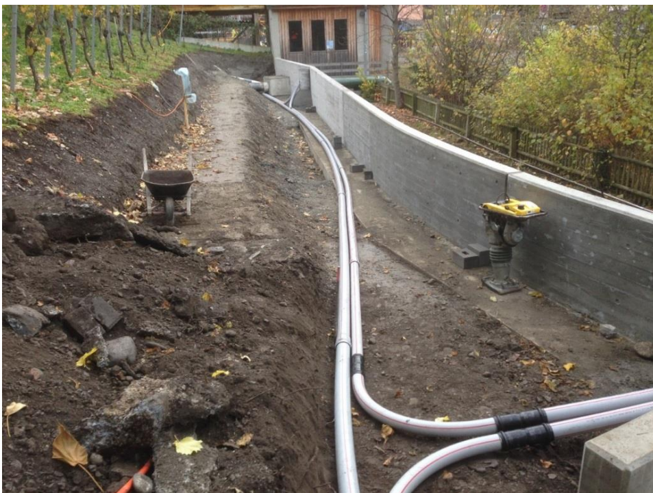
Fertig erstellte Abschlussmauer zum Mühlbach sowie Leitungen für EW und öffentliche Beleuchtung
