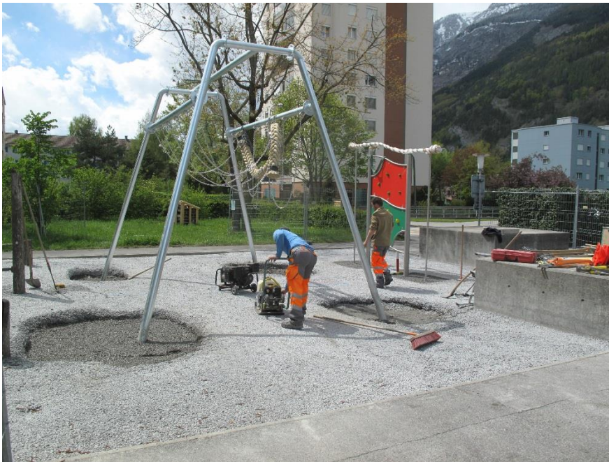
Vorbereitungsarbeiten für den Kunststoffbelags-Einbau im Schulhaus Rheinau
