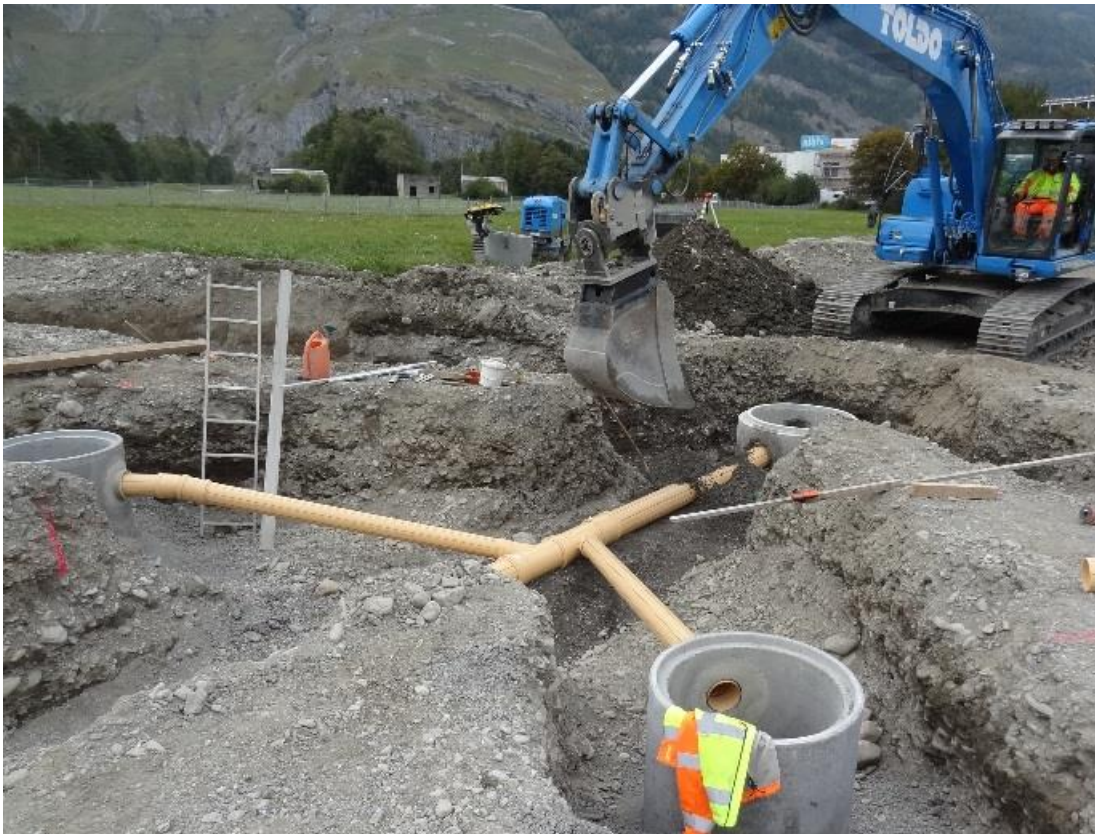
Entwässerung Oberflächenwasser
