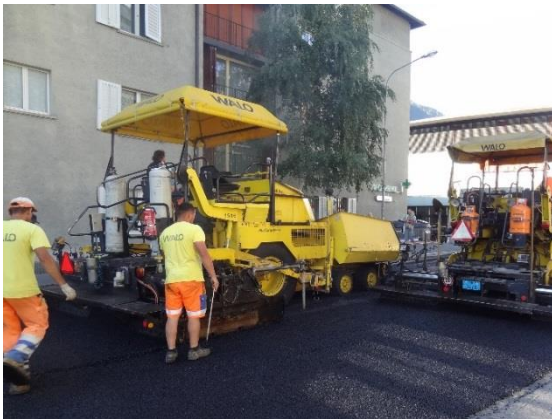
Einbau des Asphaltbelages (Stützgerüst)
