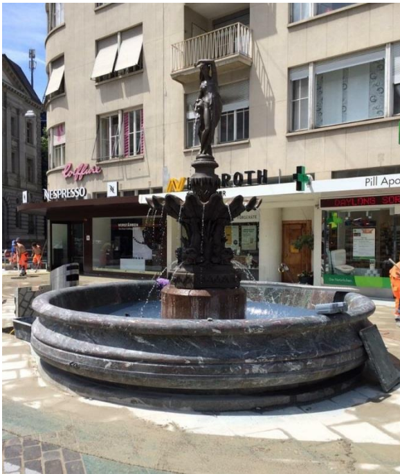
Der sanierte Postplatzbrunnen
