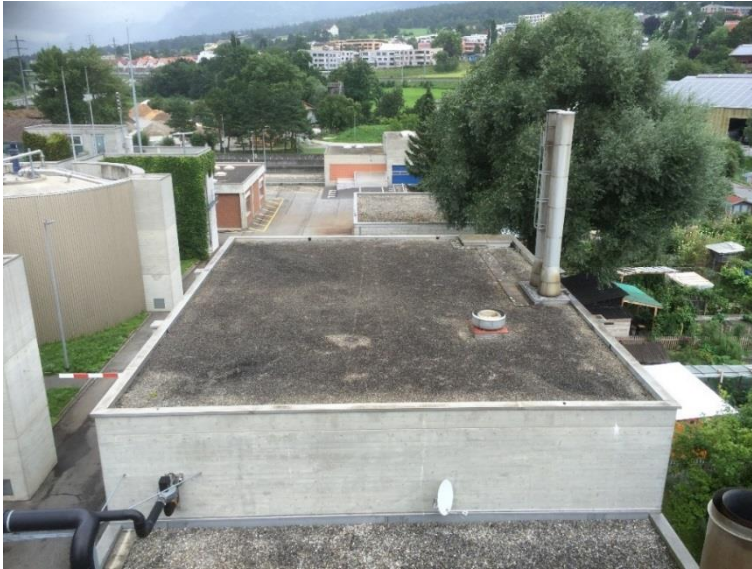
Flachdach des Schlammgebäudes
