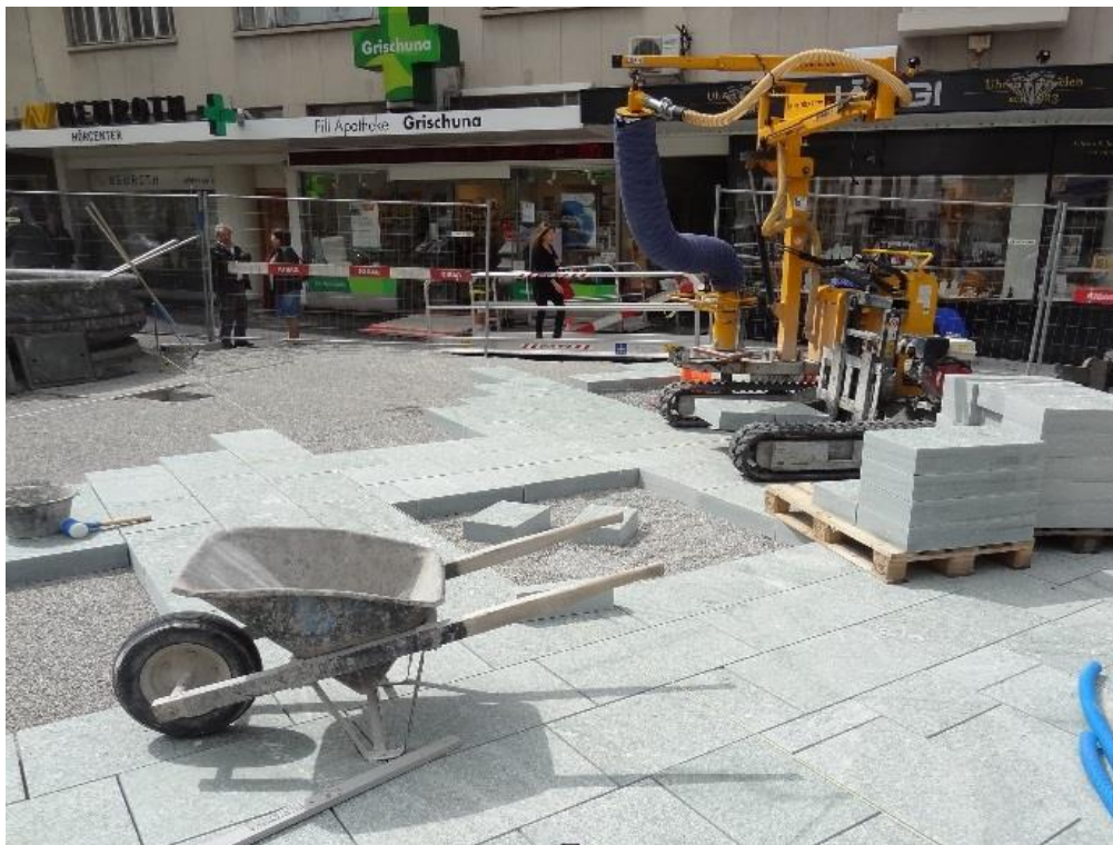
Verlegen der Natursteinplatten aus Andeerer Granit
