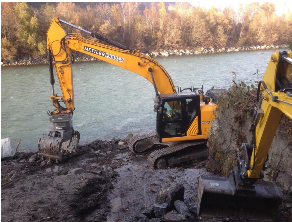
Anpassungsarbeiten Rheindamm/Auslaufbauwerk
