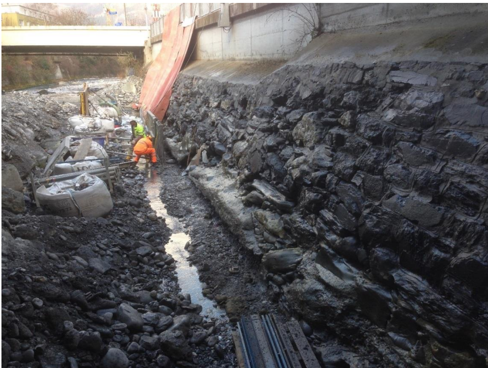
Sohlenstabilisierung der Wuhr
