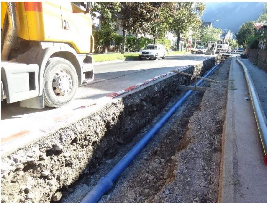
Verlegen Wasserleitung entlang Ringstrasse
