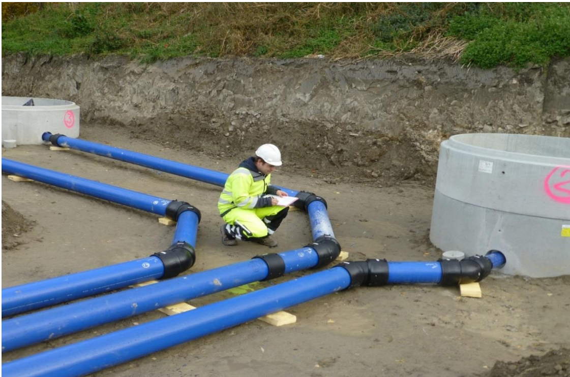
Aufnahme der Anergieleitungen Rheinfelsstrasse
