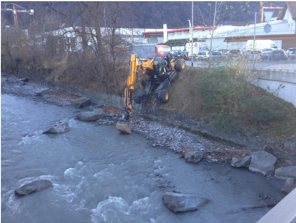
Einstieg mit Schreitbagger in die Plessur
