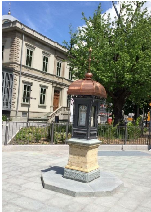
Die 110-jährige Wettersäule frisch saniert
