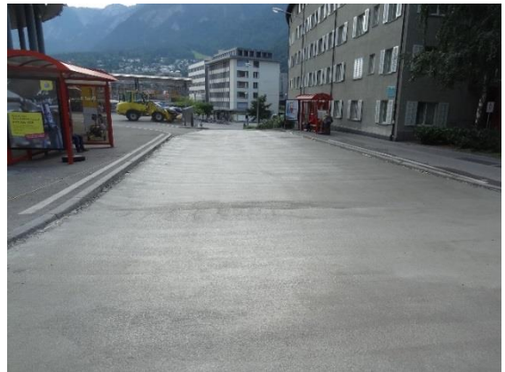
Fläche nach Einbau des Confalt Belages
