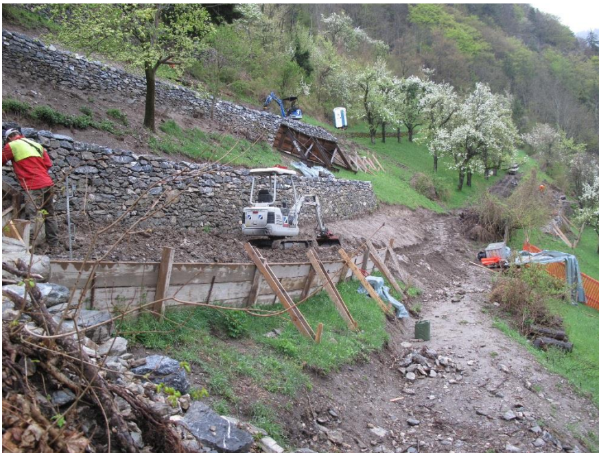
Baustelle im Seidengut während Sanierungsarbeiten
