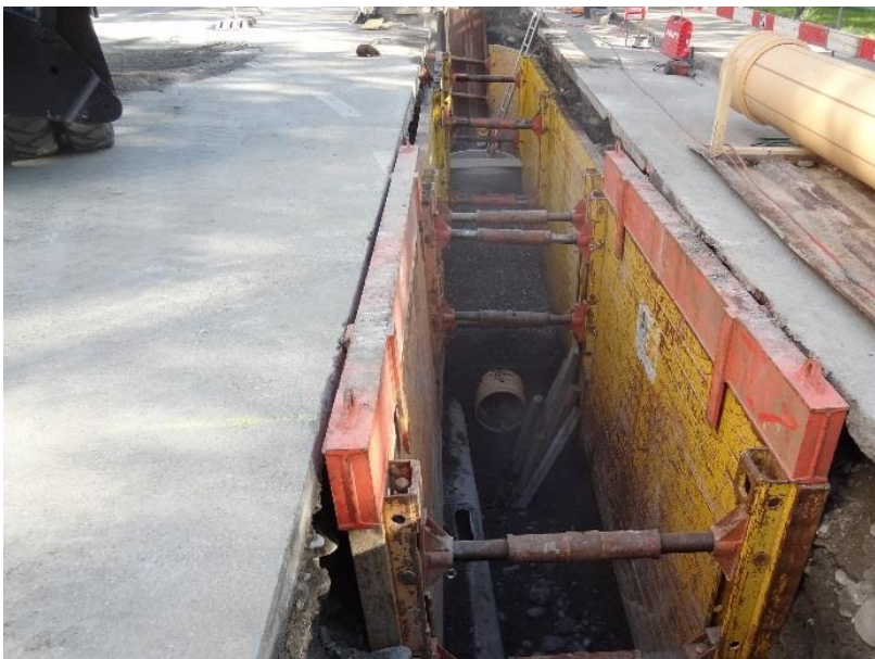
Grabenspriessung für Kanalisationsbau
