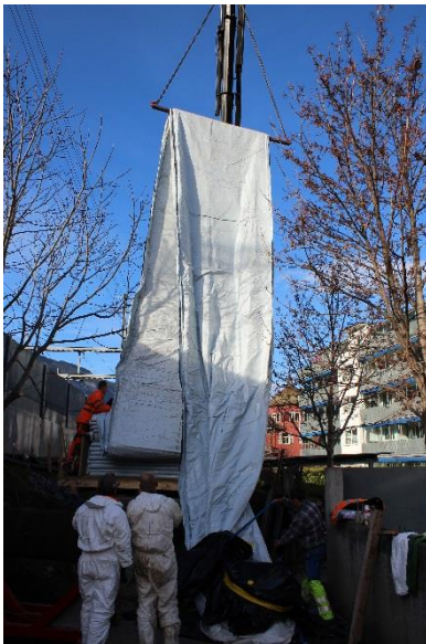
Einziehen des Inliners in die Kanalisation
