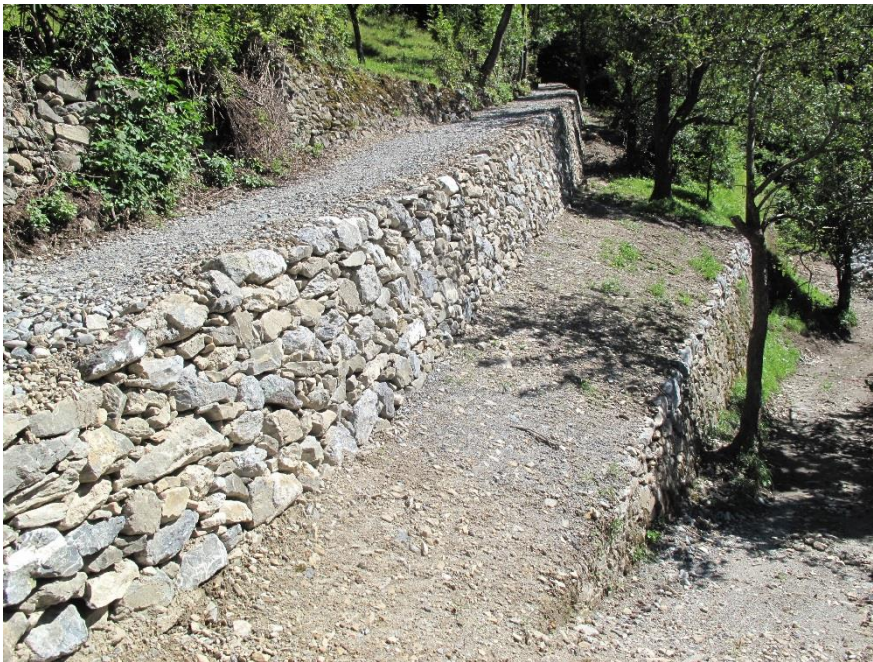
Sanierte Trockenmauern entlang der Alten Schanfiggerstrasse
