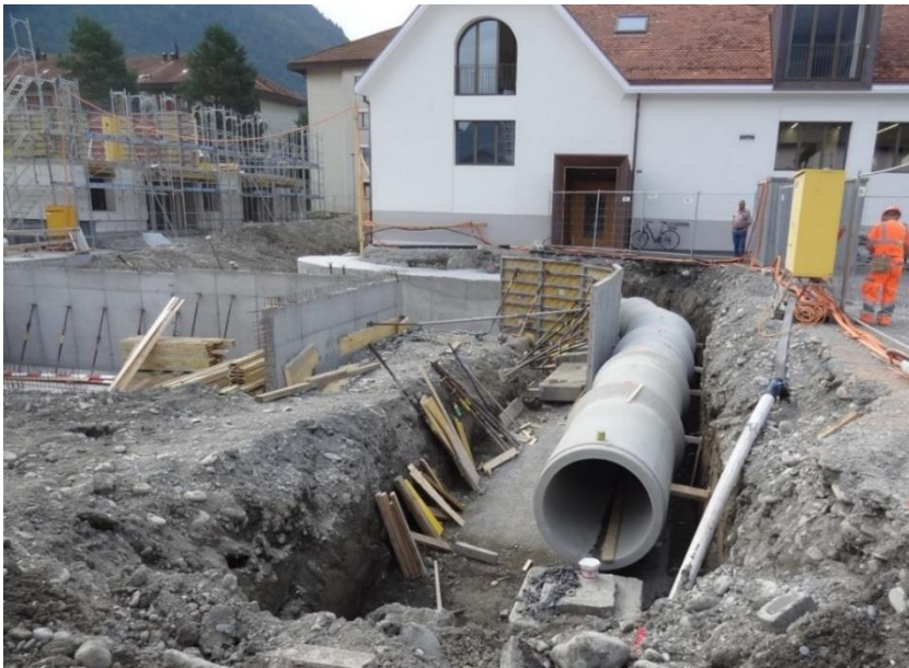
Neubau Untertorer Mühlbach im Bereich Kindergarten Calanda
