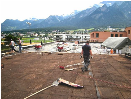
Abbrucharbeiten Flachdach Turnhalle
