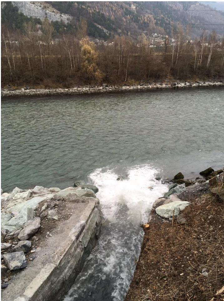
Der fertig erstellte neue Einlauf in den Rhein
