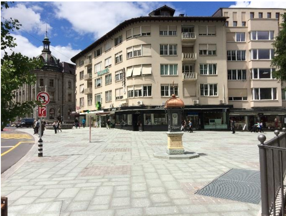
Postplatz mit sanierter Wettersäule und Abdeckung Eingang neue Transformatorenstation
