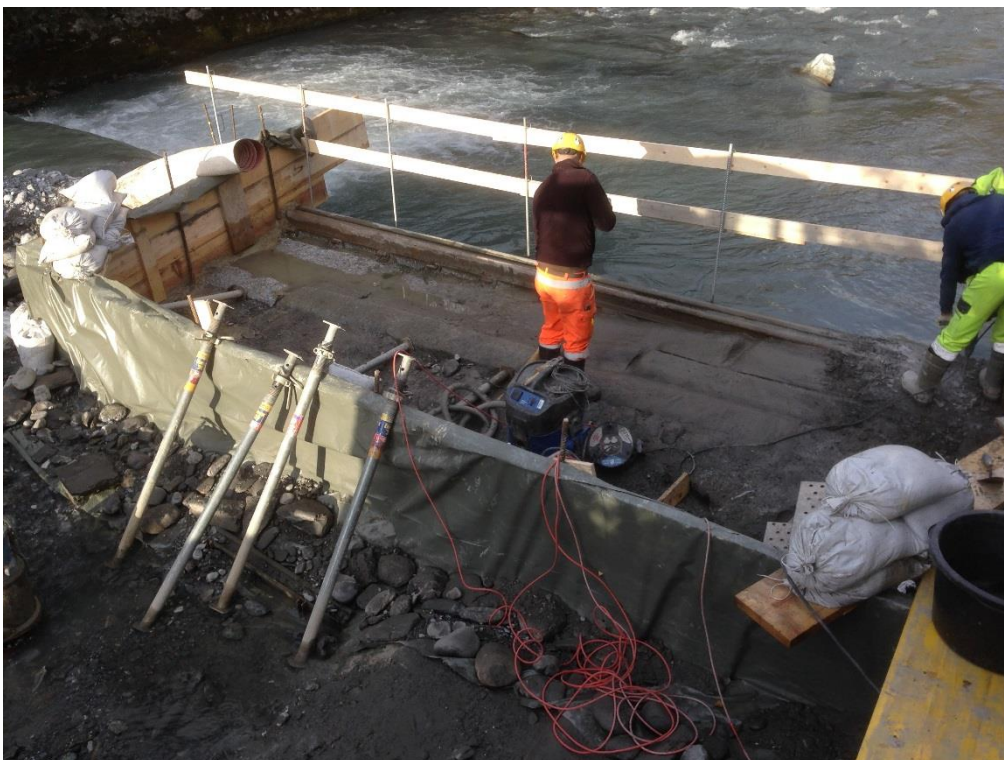
Vorbereitungsarbeiten zur Schwellensanierung
