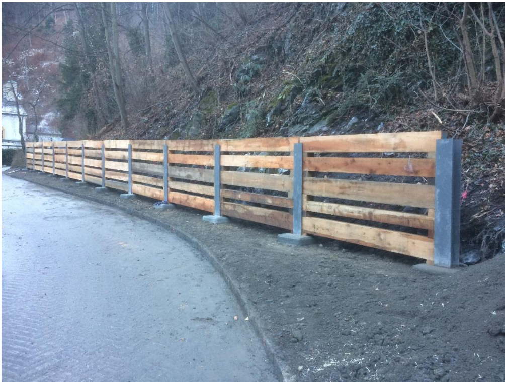
Steinschlagschutzwand aus Churer Lärchenholz in Eigenregie gebaut
