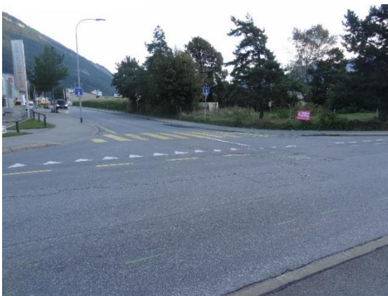
T-Kreuzung vor Baubeginn
