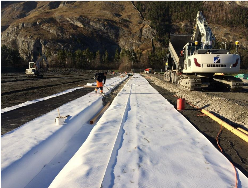
Einbau der Abdichtung und der darüber liegenden Entwässerung
