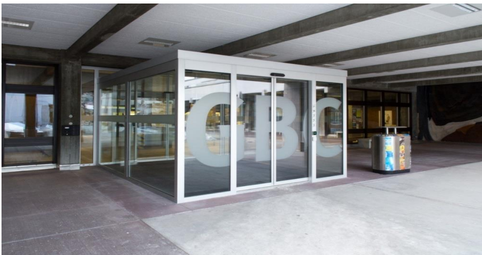
Neuer Windfang GBC
