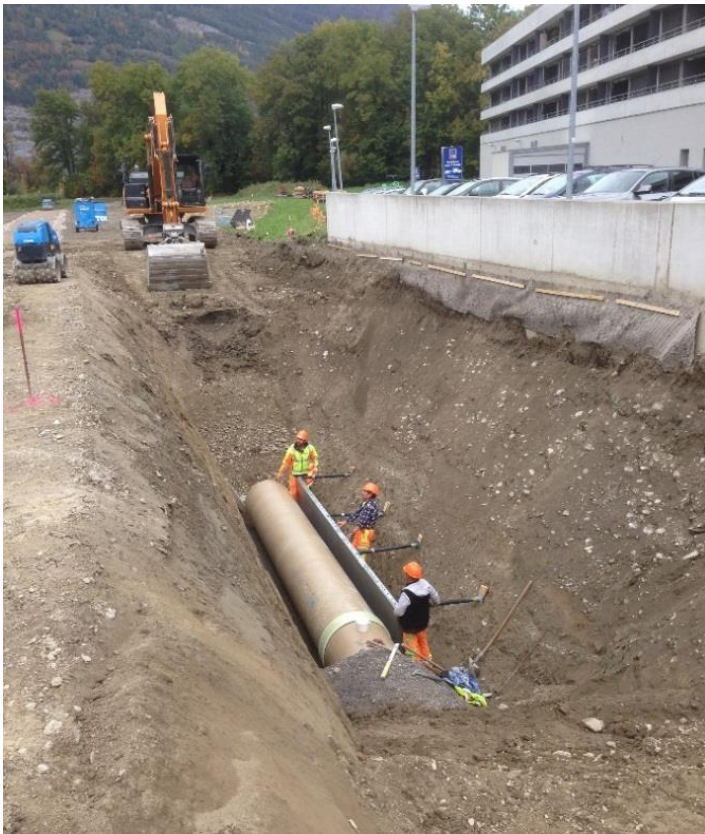
V-Grabenprofil mit Abwasserleitung 900 mm
