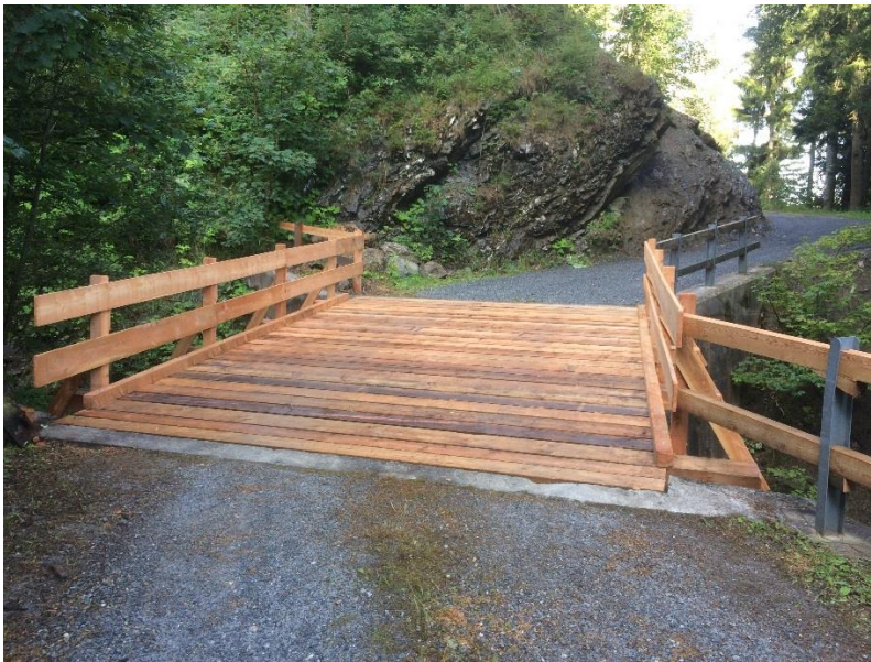
Selbstgemacht - aus Churer Lärchenholz sanierte Brücke im Schwarzwald. Traglast 56 Tonnen
