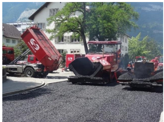
Verlegen der Asphaltarmierung und Belagsarbeiten
