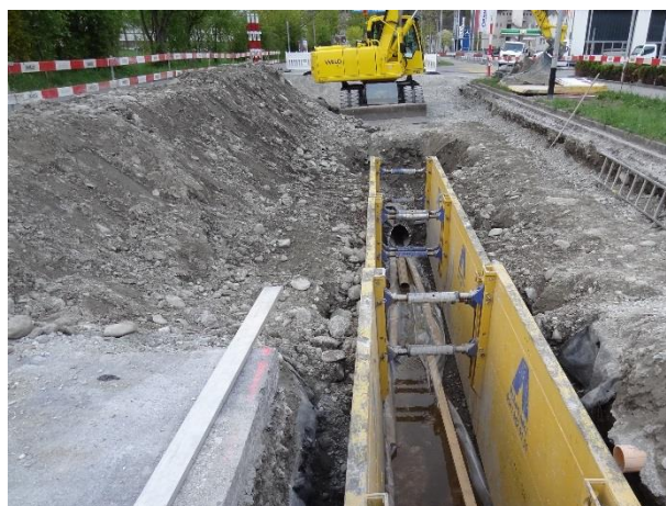
Kanalisationsbau Ringstrasse
