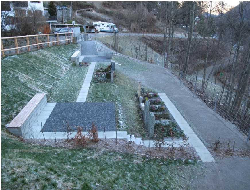
Friedhof Araschgen kurz nach den Fertigstellungsarbeiten
