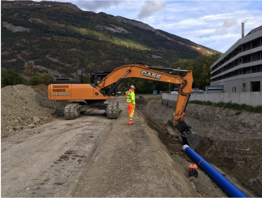
Grab- und Verlegearbeiten der Kanalisations- und Anergieleitungen
