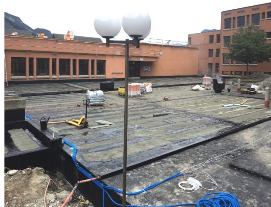
Abdichtungsarbeiten Pausenplatz
