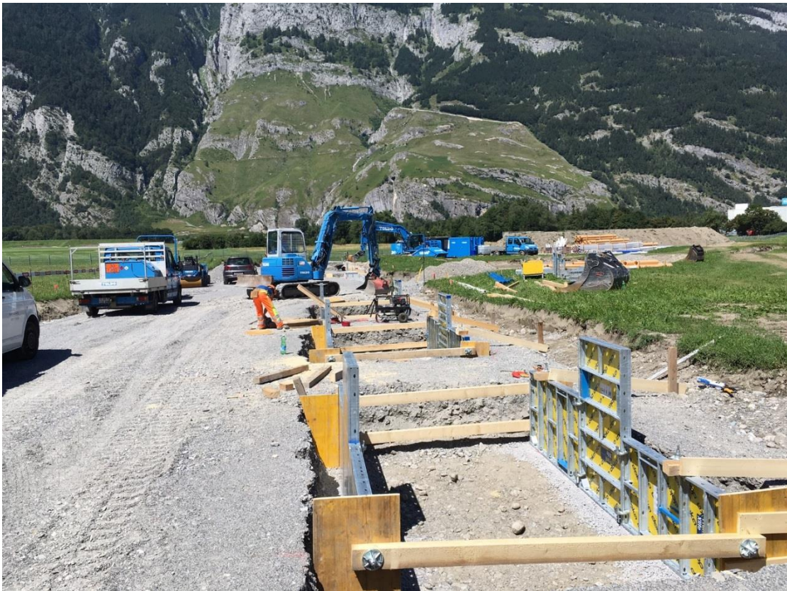
La-Nicca-Strasse mit im Bau befindlichen Baumgruben
