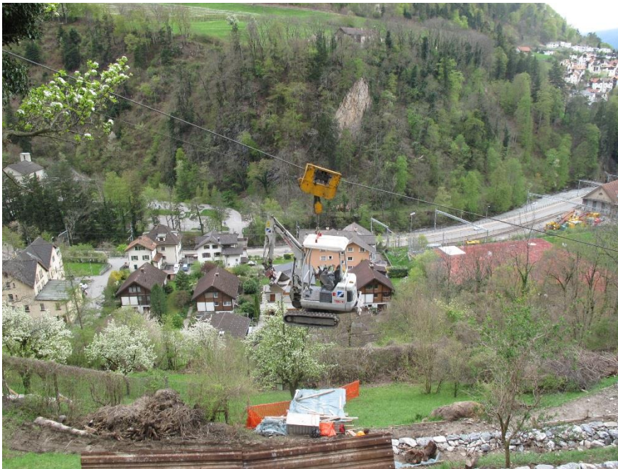
Material und Maschinen wurden im Seidengut mit der Seilbahn transportiert
