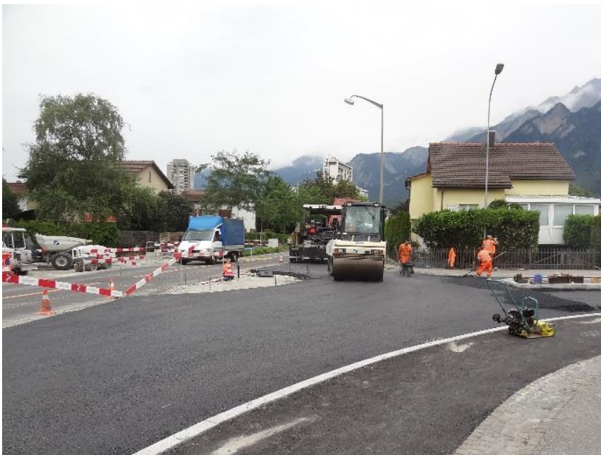
Belagseinbau Fahrbahn Kreis
