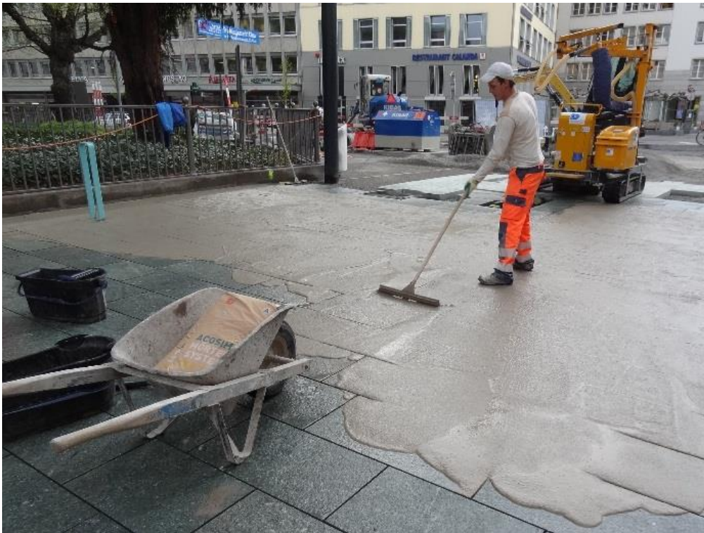
Ausfugen der Pflästerung mit Traskalk
