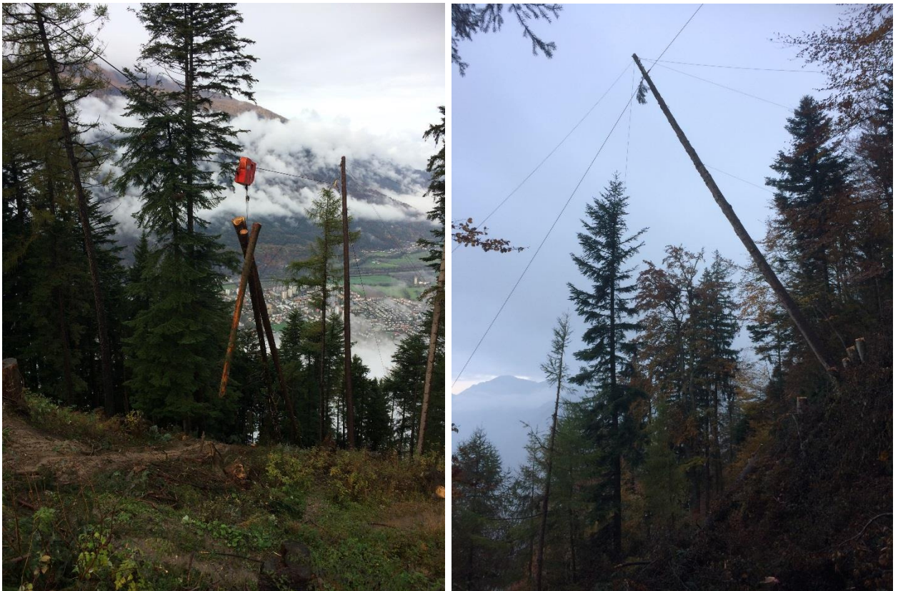
Mittels Seilkran mit mobilen Stützen mit über 25 m Seilhöhe wird das Holz aus den Hängen am Pizokel transportiert
