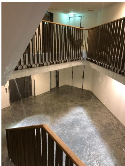
Wasserschaden im Gebäude "Steinbock" auf dem Bahnhof Chur aufgrund einer geplatzten Leitung
