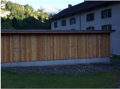
Schöpfe zur Holzlagerung
