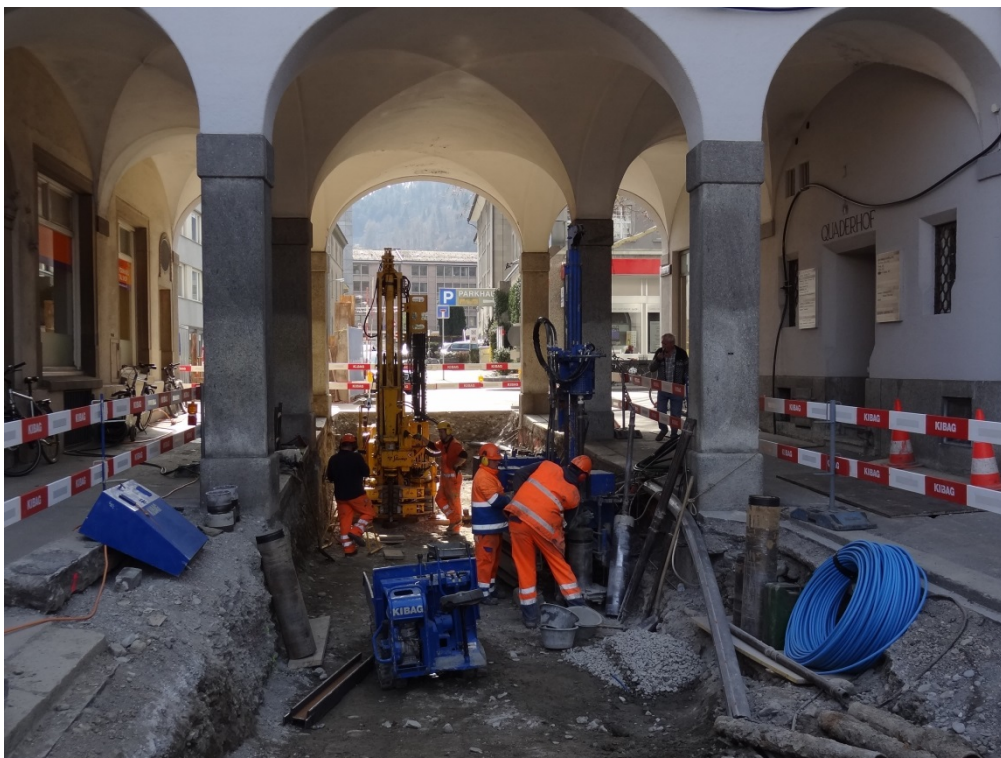
Bohrungen für Rühlwandträger.
