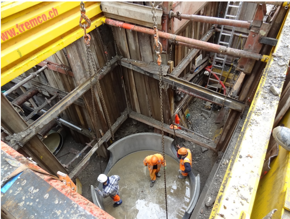
Versetzen des Kontrollschachts mit 3.00 m Durchmesser.
