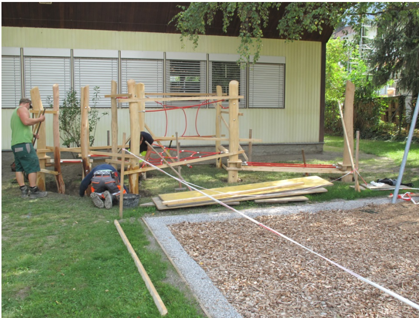
Kindergarten Herold: Städtische Mitarbeitende beim Versetzen eines Balancierwegs.
