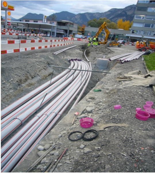
Vermessung Werkleitungen im Bereich Ring-/Rheinfelsstrasse.
