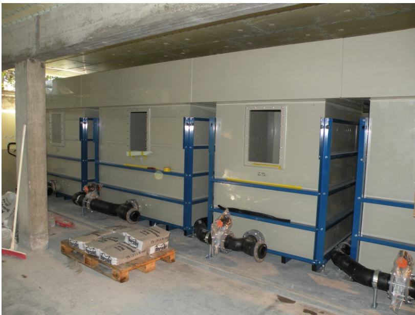
Einbau der neuen Filter im Freibad Obere Au.
