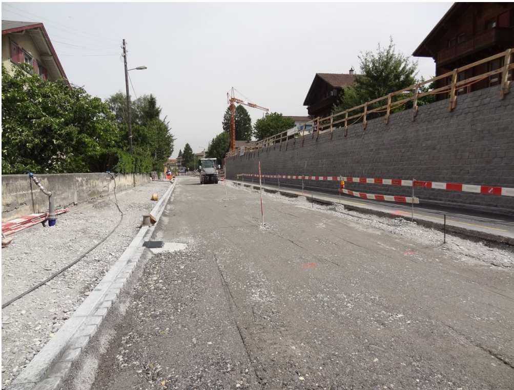
Ausbau Strasse talseitig.
