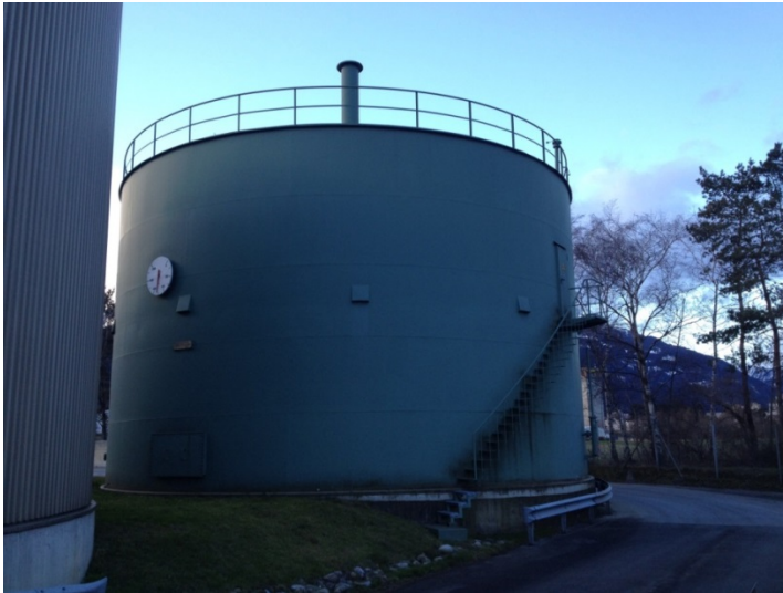
Aussenansicht des Gasometers.
