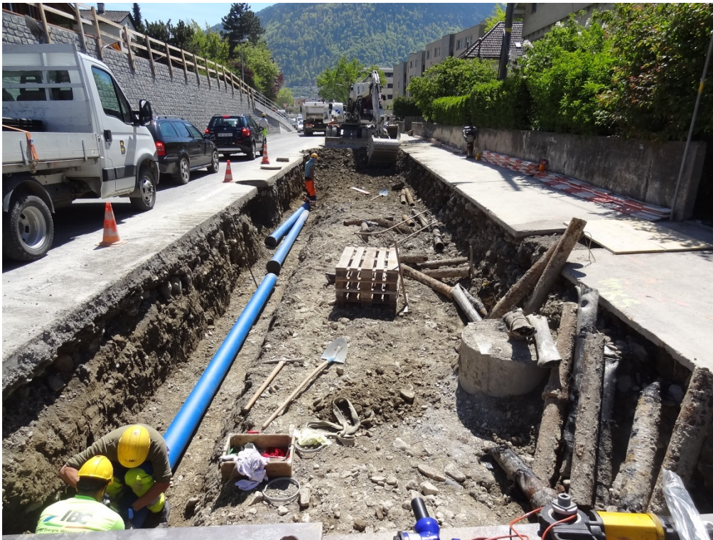
Verlegen Wasserleitung.
