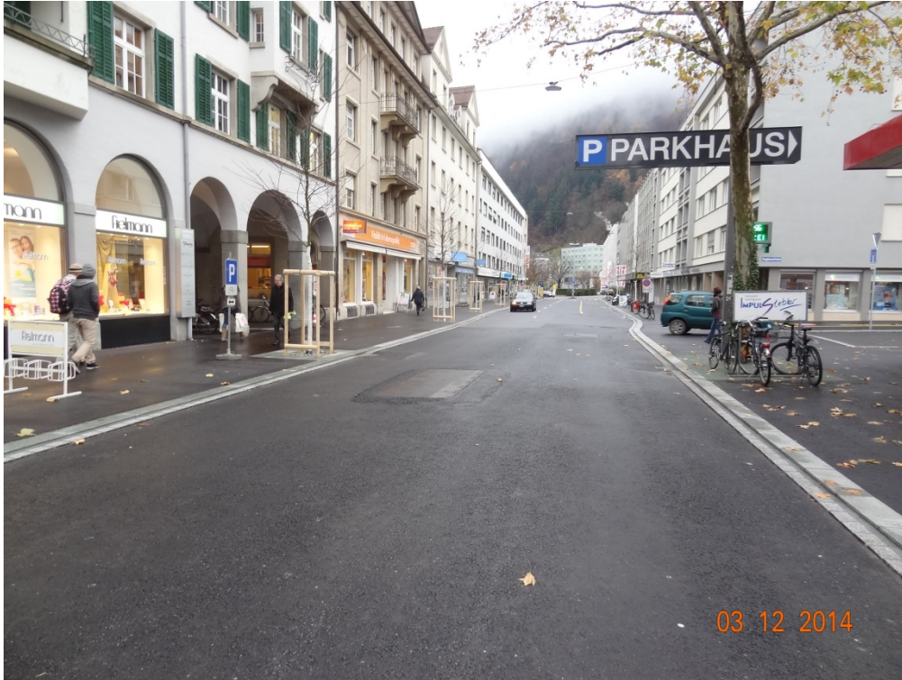
Die fertiggestellte Quaderstrasse.
