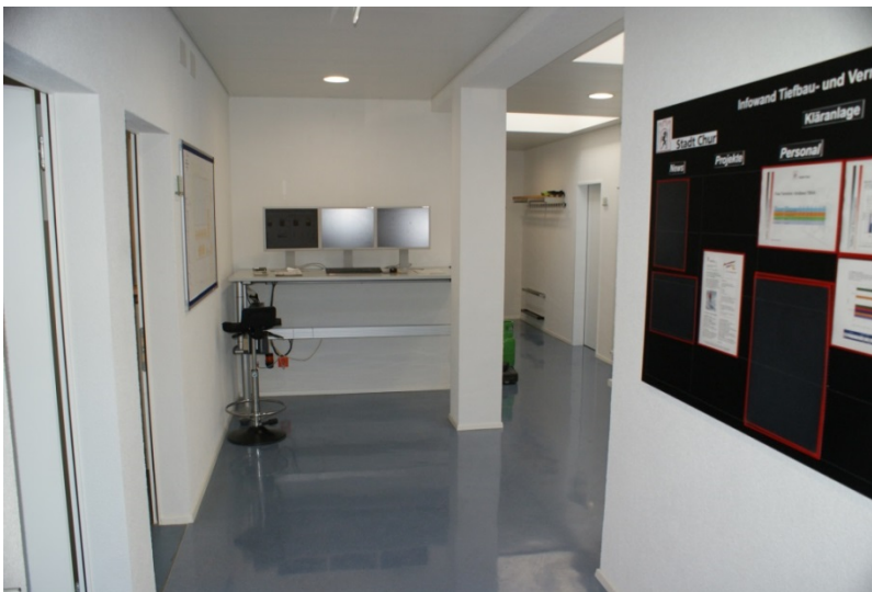
Innenansicht des umgebauten Betriebsgebäudes.
