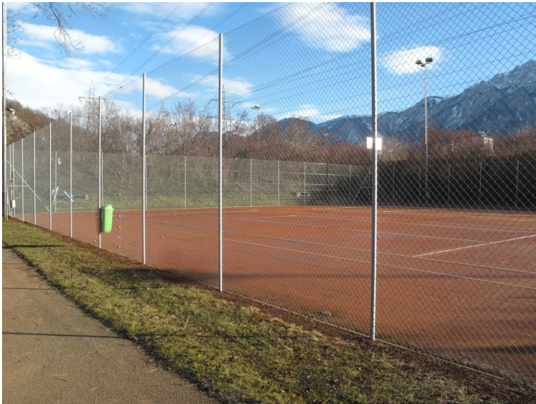
Tenniscenter: Sanierter Ballfang Feld 5 und 6.
