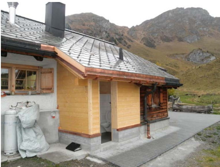
Bergrestaurant Ochsenalp - Anbau zweites WC und Erweiterung der Pflasterung.
