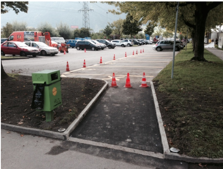
Obere Au: Zusätzliche Parkplätze für behinderte Personen erstellt.
