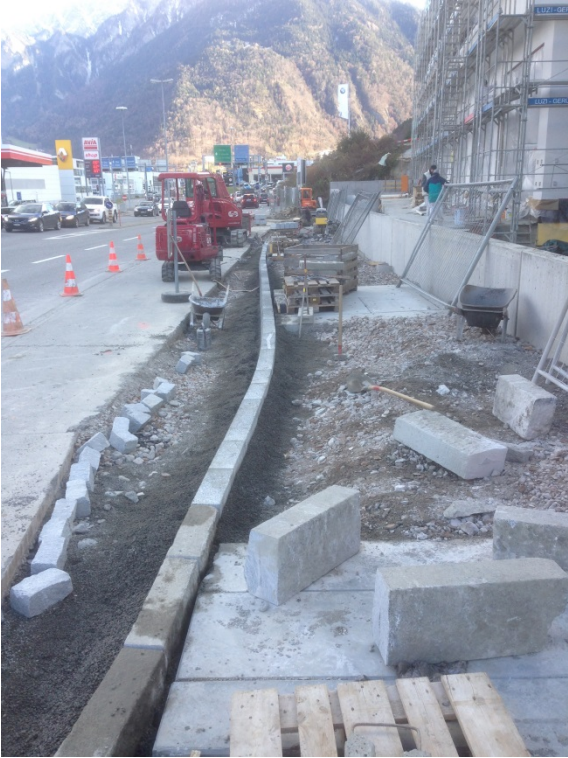
Die neuen Randabschlüsse werden gesetzt.
