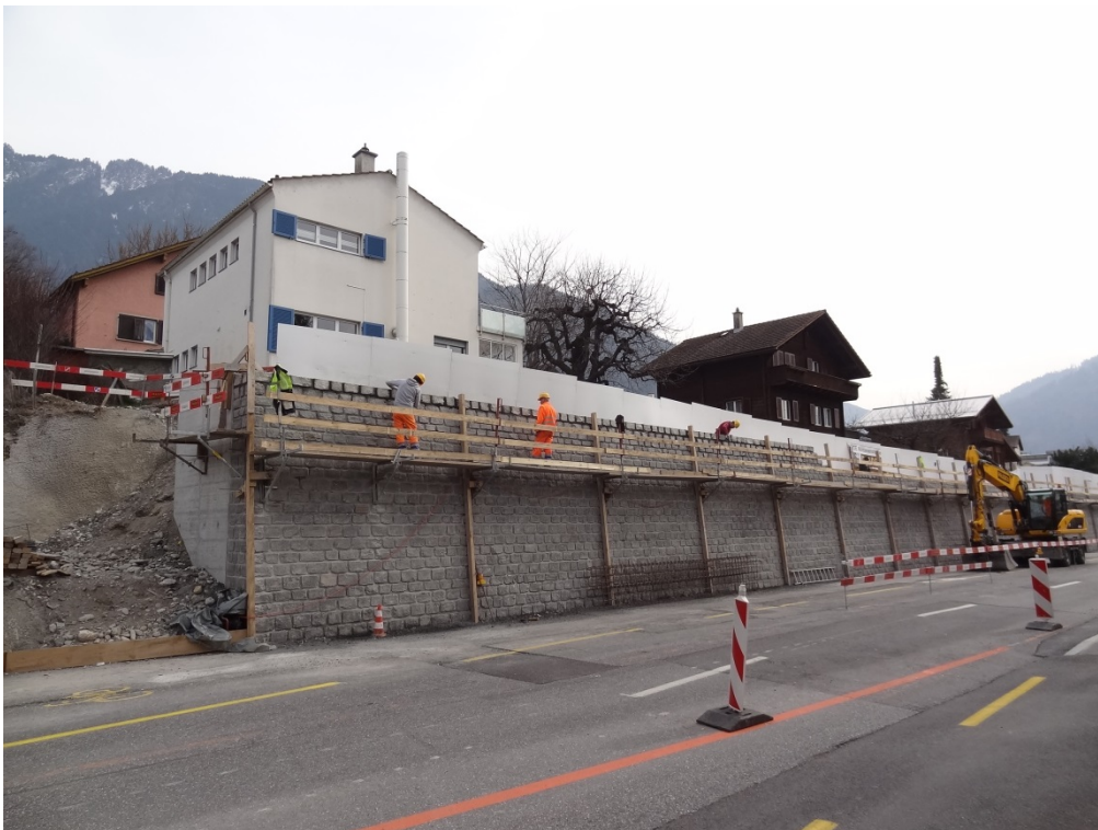
Fertigstellung Schwergewichtsmauer mit Natursteinverkleidung.
