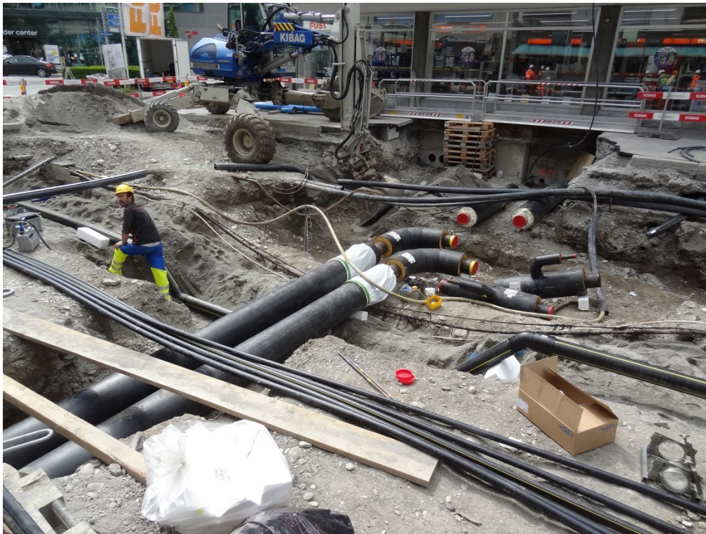
Bau Fernwärmeleitung.
