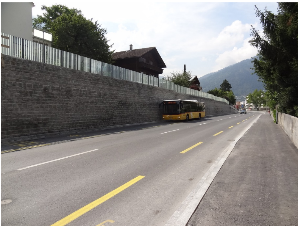
Endausbau mit Lärmschutzverglasung.
