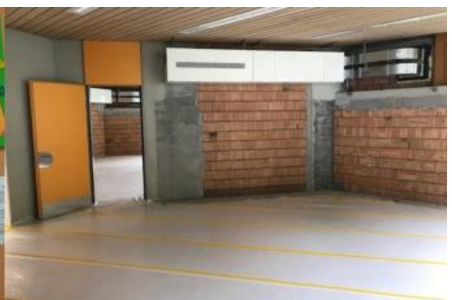
Türligarten: Baustelle Schulzimmer
