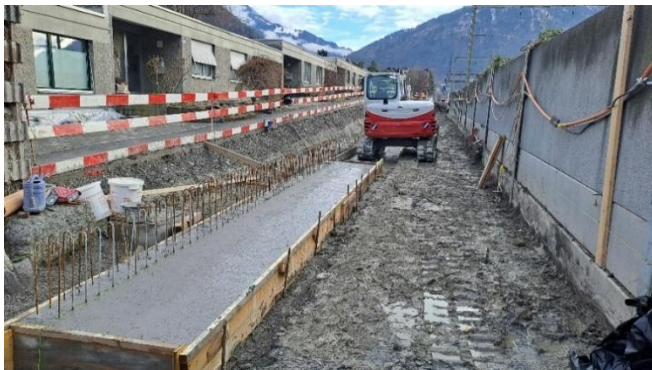
Impression laufende Baustelle
