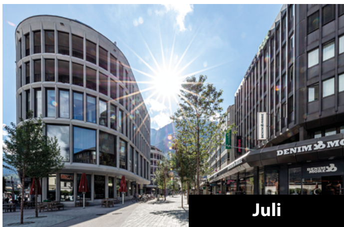
Die neue Fussgängerzone Steinbockstrasse wurde der Bevölkerung übergeben. Nach einer sehr intensiven Bauzeit mit vielen komplexen Bauphasen konnte die neu gestaltete Steinbockstrasse am 3. Juli als Fussgängerzone offiziell eröffnet werden.
