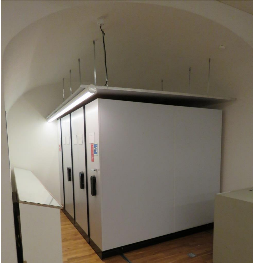
Metallabdeckungen schützen die Rollregalanlagen im Magazin 2 neu vor eindringendem Wasser (Foto Stadtarchiv)
