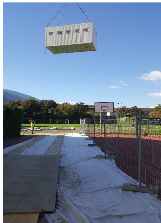
Hebe-/Platzierungsvorgang eines Modulcontainers mit 300t Kran
