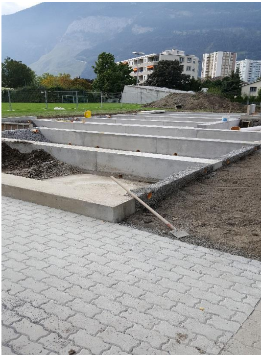
Fundament für die Modulcontainer
