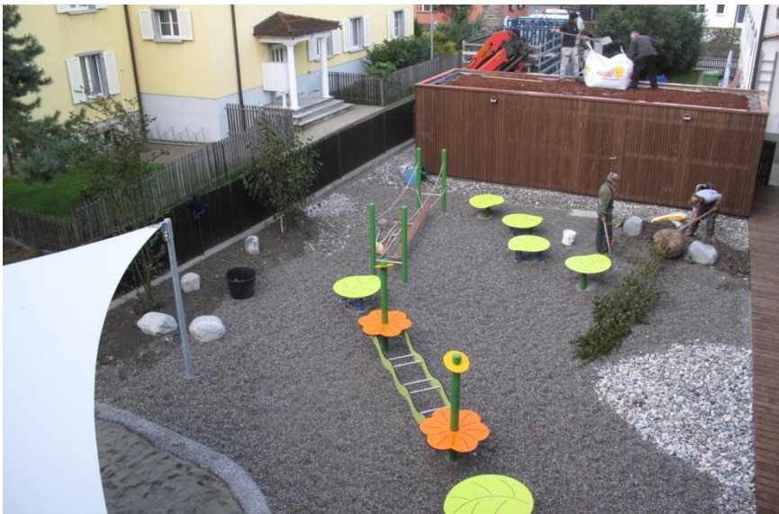
Fertigstellung Aussenraum mit Geräteschopf Kindergarten Calanda
