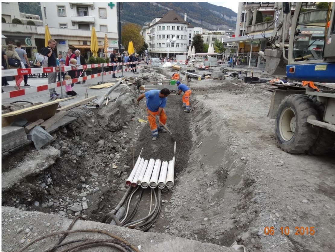
Werkleitungsarbeiten EW-Trasse
