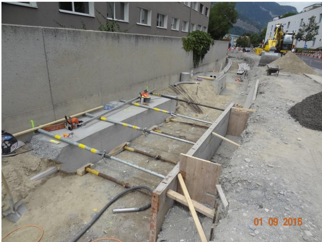
Fundamente für Baumgruben mit EW-Trasse
