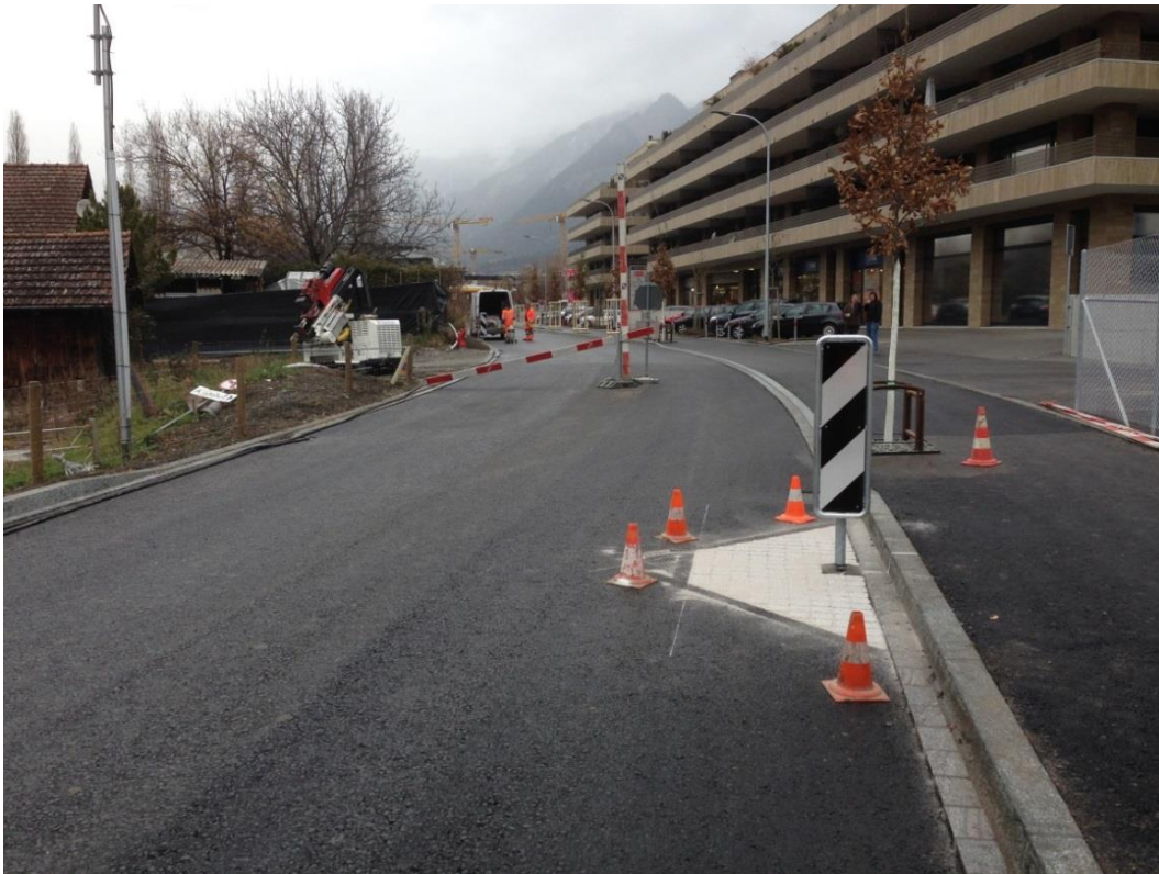
Markierungsarbeiten Einengungen Zone 30
