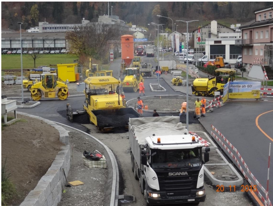
Belageeinbau Kreisel Ringstrasse
