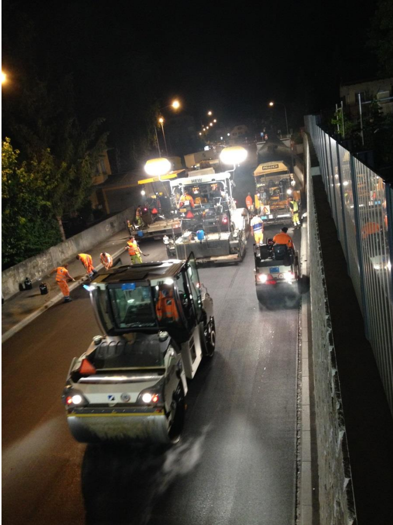
Einbau Deckbelag an der Masanserstrasse
