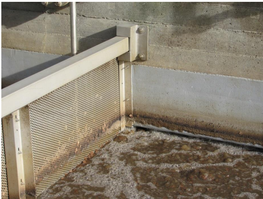
Beschichtete Belüftungsbecken
