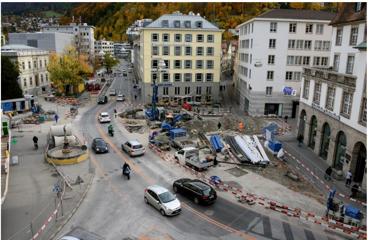
Arbeiten 1. Etappe mit provisorischer Verkehrsführung
