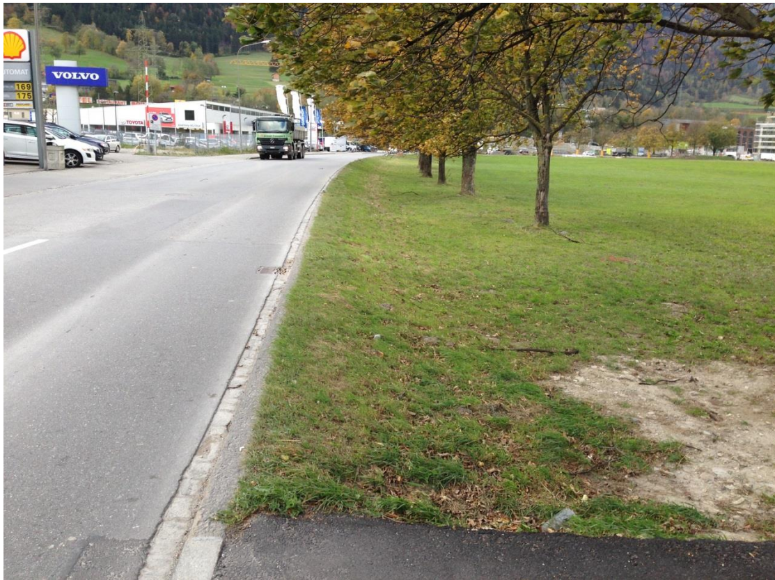
Rossbodenstrasse vor Baubeginn Rad- und Gehweg
