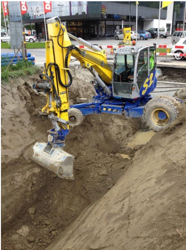
Aushub Anschluss Kanalisationsleitung Rheinfels- / Raschärenstrasse
