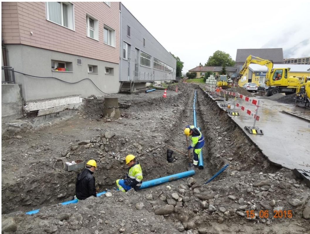
Einbau der Wasserleitung IBC
