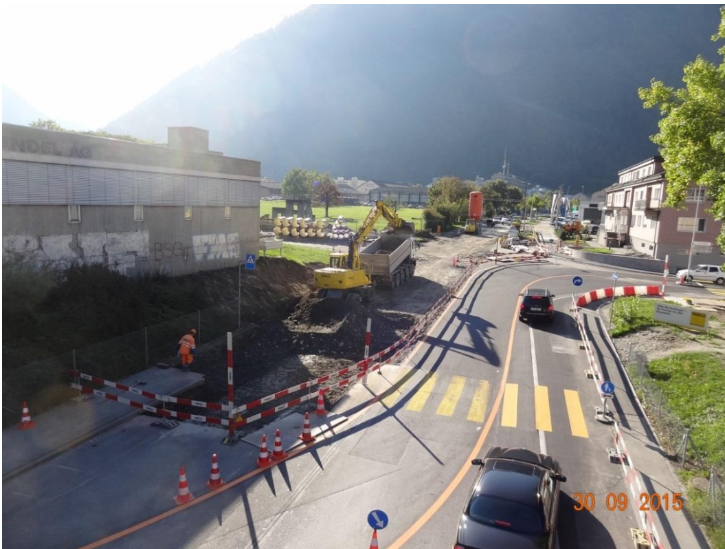
Bauarbeiten Seite Salvatore- / Ringstrasse
