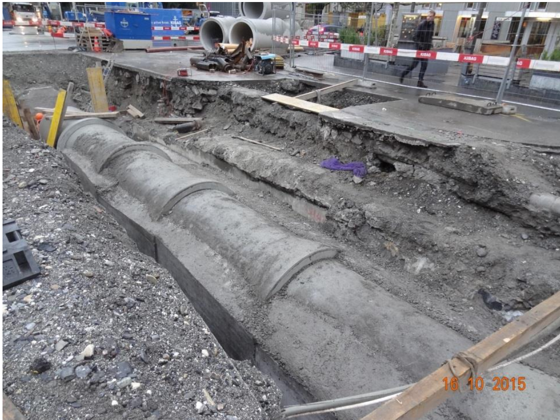
Neue Zementrohre des Mühlbachs
