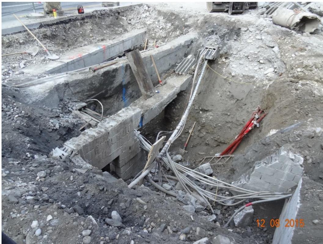
Aushub für neue Kanalisationsleitung
