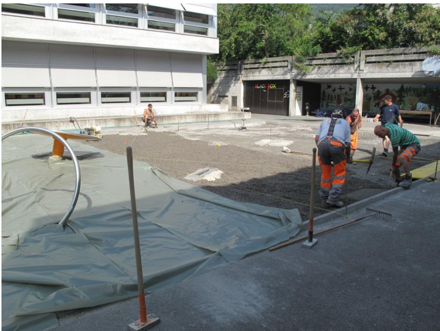
Schulhaus Lachen: Vorbereitungsarbeiten für neuen Fallschutzbelag
