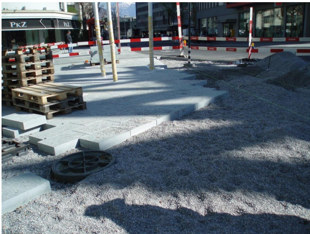
Versetzen der Natursteinplatten um die „Lotusblüten“
