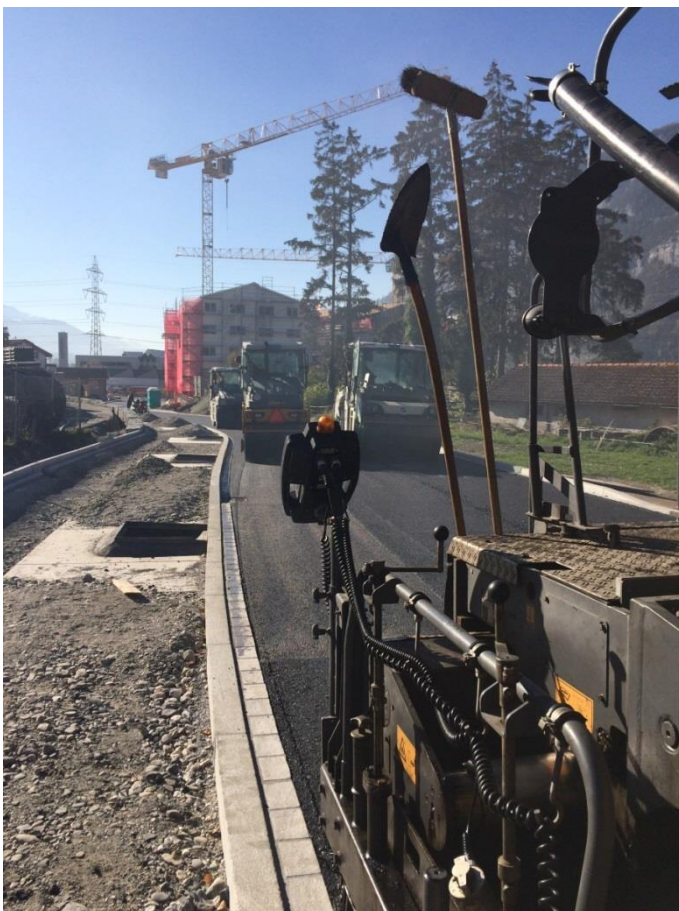
Belageinbau Rheinfelsstrasse
