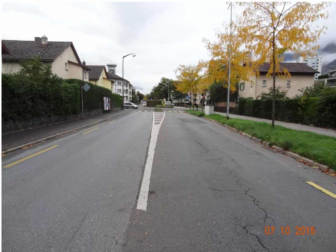
Schadensbild Ringstrasse vor Sanierung Deckbelag (Scalettastrasse – Nordstrasse)
