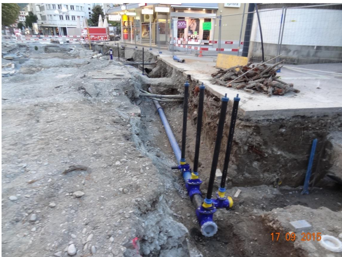
Neue Wasserleitung der IBC Energie Wasser Chur
