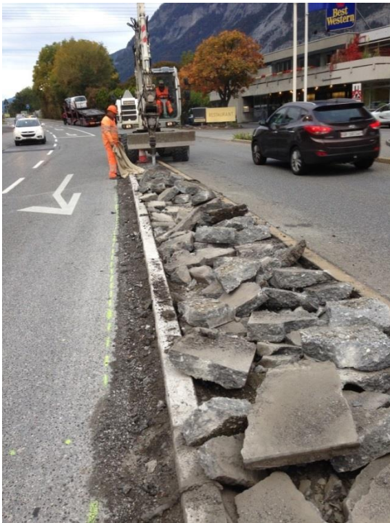
Rückbau der Mittelinsel
