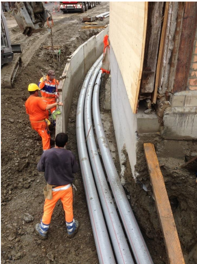
Schalung EW-Kabelblock entlang Haus Passanante
