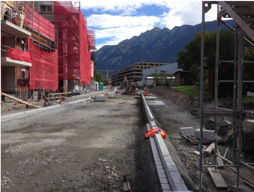
Versetzen der Wasser- und Randsteine
