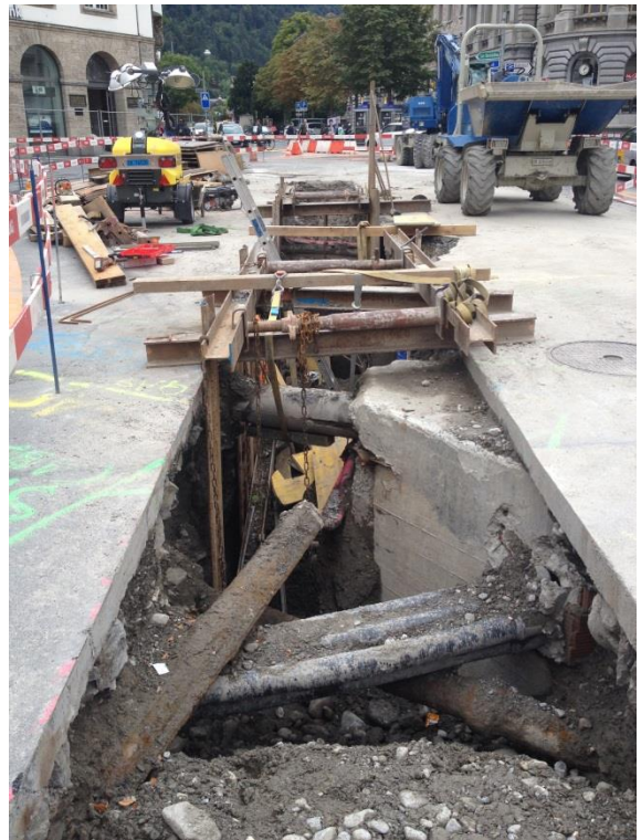
Erstellen der neuen Kanalisationsleitung
