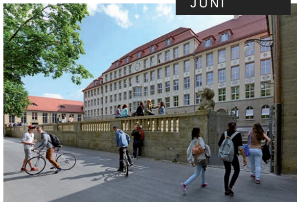
Nach knapp zweijährigen Sanierungsarbeiten des Schulhauses Quader fand am 14. Juni ein Tag der offenen Tür statt, welcher bei der Bevölkerung auf grosses Interesse stiess.
