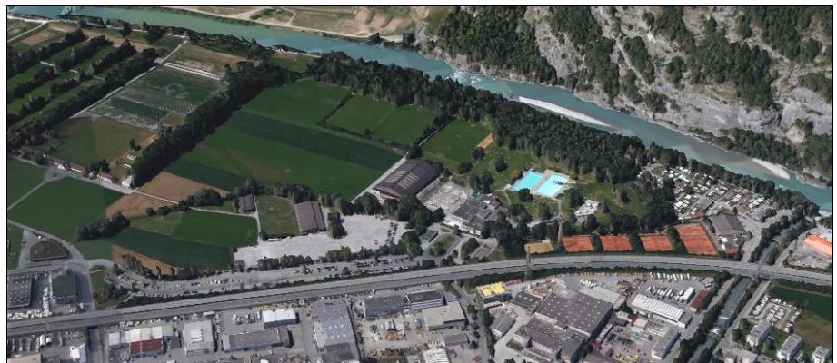
Abb.1: Übersicht über das Gebiet Obere Au, Chur (Quelle: googleEarth)
