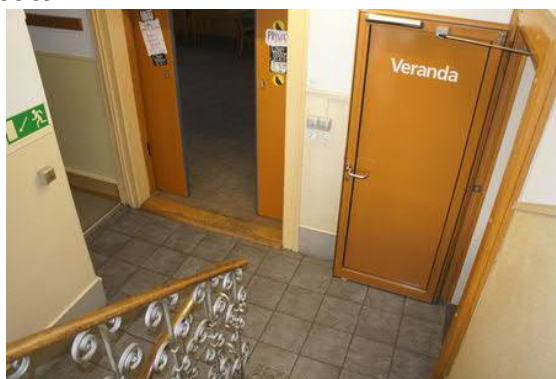
Podest 1. OG mit neueren Platten
