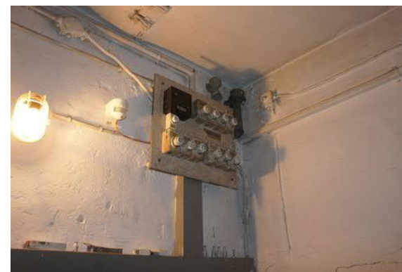
Elektrounterverteilung Keller
