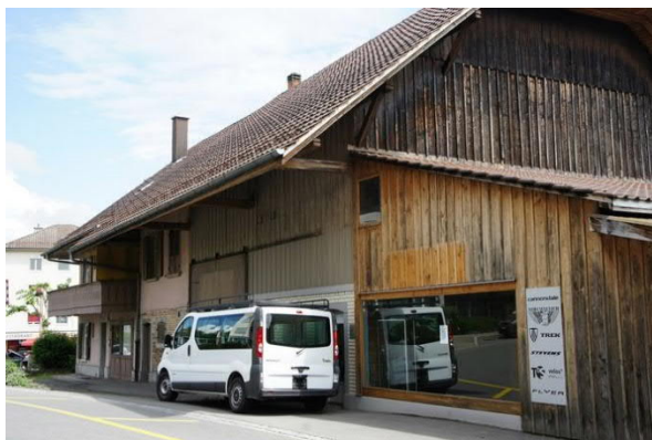
Angebauter Lagerraum mit Verkaufsfläche von aussen
