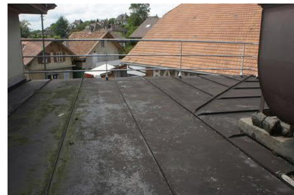
Blechdach über Anbau
