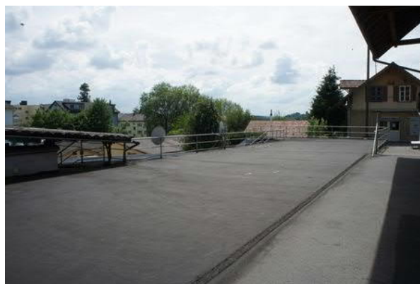
Flachdach über alter Kegelbahn
