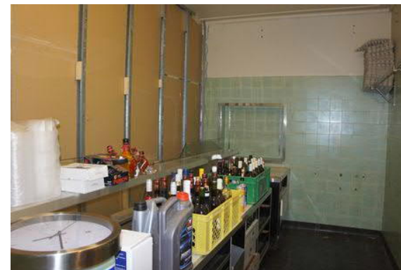
Nebenraum mit eingebauter Leichtbauwand
