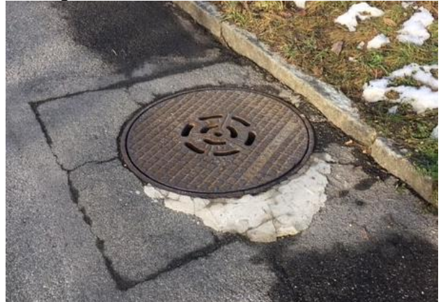
Abb. 5 Schachtdeckel mit Reparaturstelle
