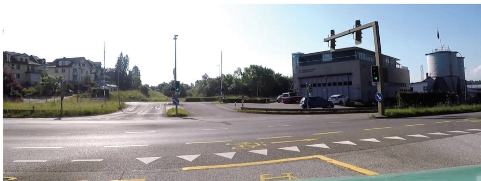
Abbildung 15: Anschluss übergeordnetes Strassennetz [eigene Aufnahme]
