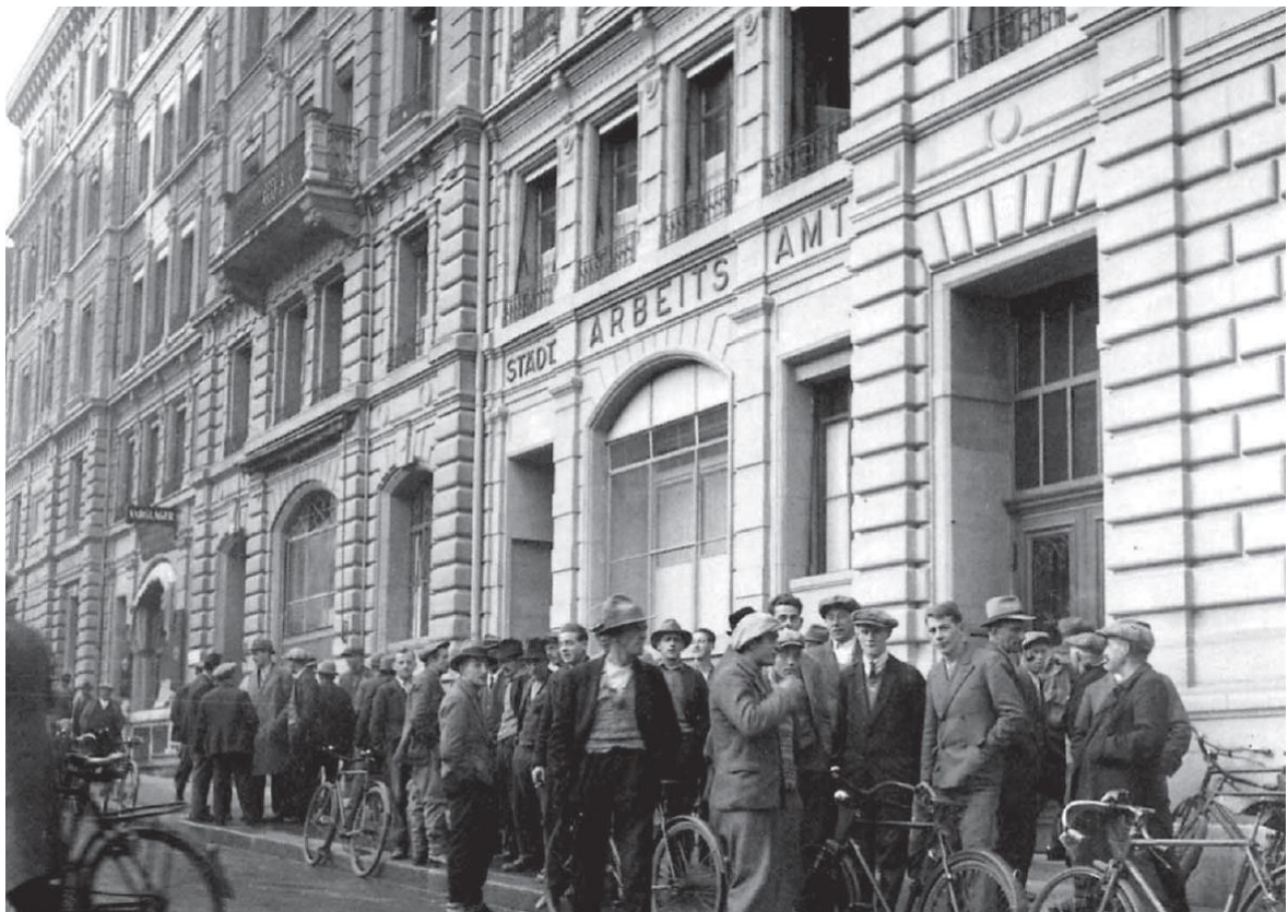
Fassadenansicht Predigergasse 4-10, Archivbild
