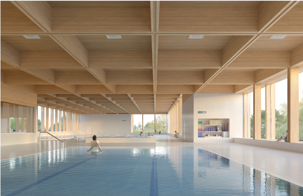
Nichtschwimmerbecken mit Schwimmerbecken im Hintergrund
