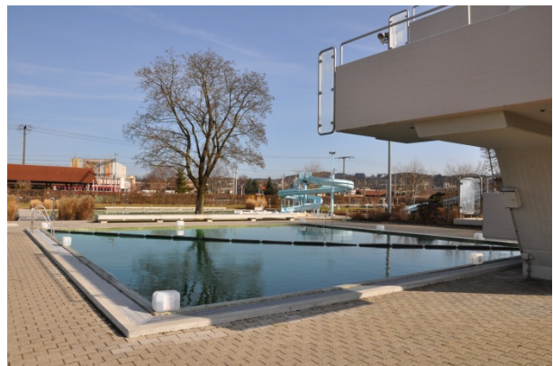
Sprungbecken mit Sprungturm
