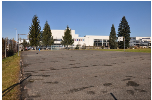
Trockenplatz (bituminöser Belag)
