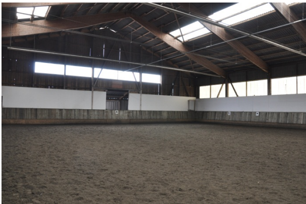
Reithalle mit Zuschauergalerie
