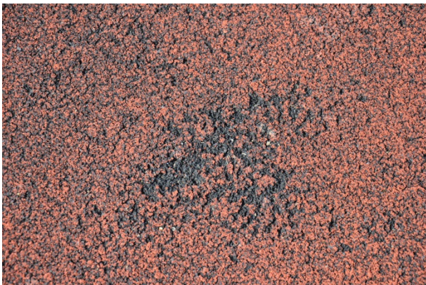
Belagsschaden Laufbahn
