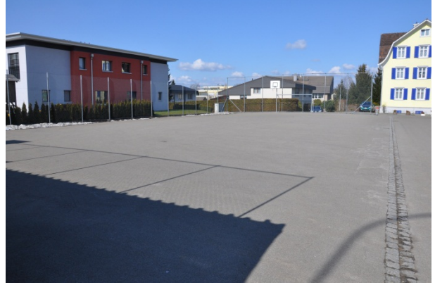
Trockenplatz (bituminöser Belag)
