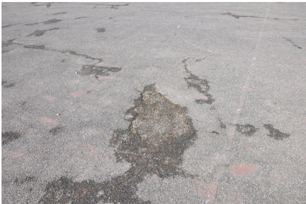
Belagsschäden Trockenplatz
