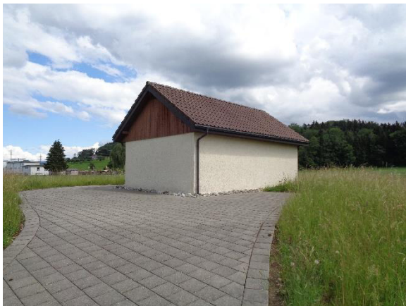
Abb. 4.1: Ansicht GWPW Schwimmbad II (Foto L&H 18.6.2020)
