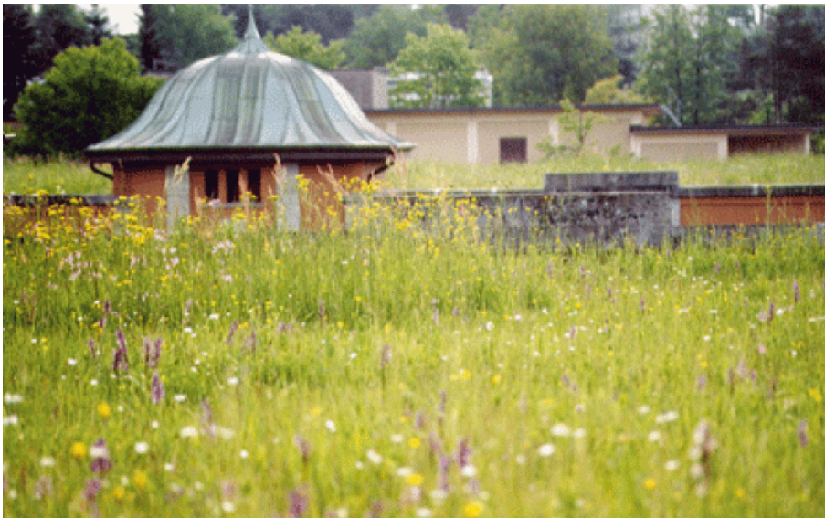
Abb. 9: Begrünung auf den Dächern des Seewasserwerkes Moos in Zürich.
