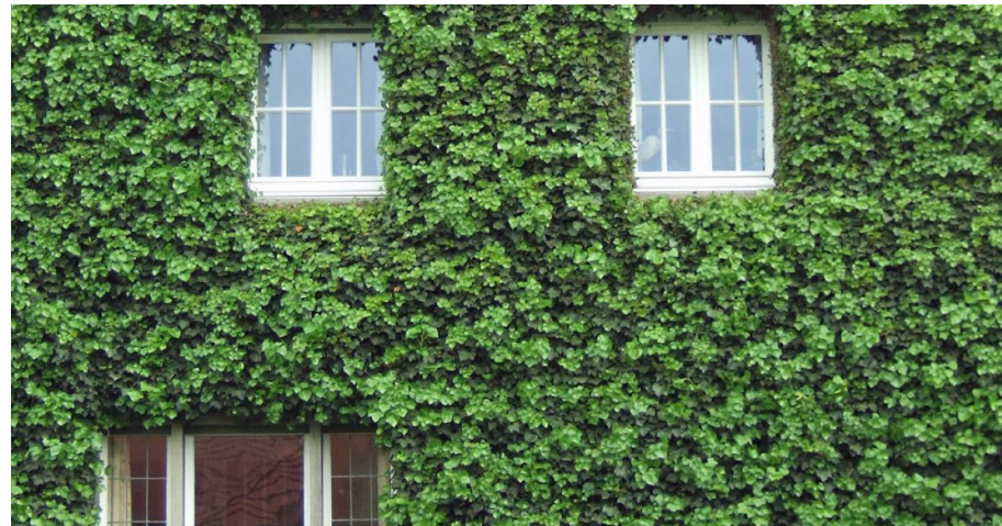
Abb. 11: Beispielhafte Fassadenbegrünung mit Efeu.
