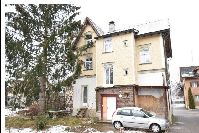
Fassade gegen Osten
