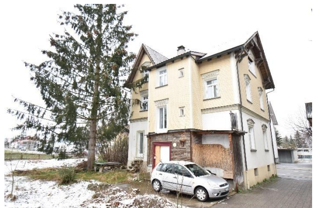
Fassade gegen Nordosten
