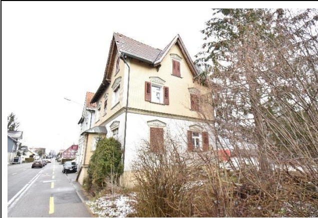
Fassaden gegen Südwesten
