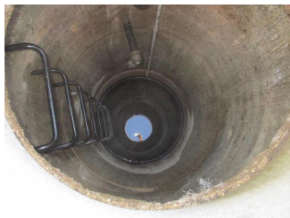
Abb. 4.5: Blick in den Quellschacht Herzenwil (Foto L&H 1.3.2022)
