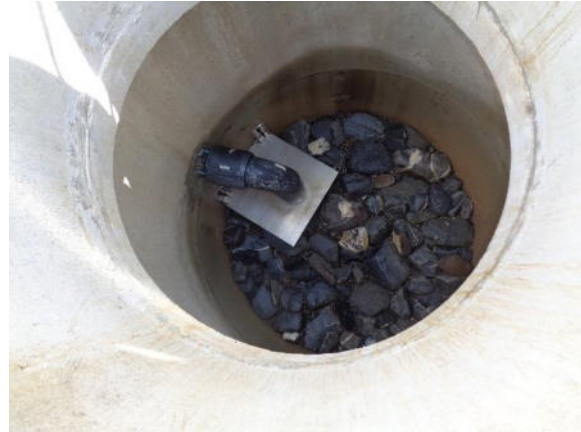
Abb. 4.7: Blick in den Sickerschacht (Foto L&amp;H 18.6.2020)
