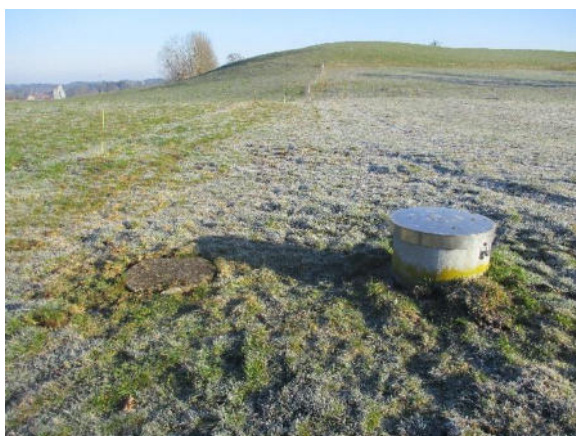
Abb. 4.4: Quellschacht Herzenwil (rechts) und Kontrollschacht vom eingedolten Bach (links) (Foto L&H 1.3.2022)
