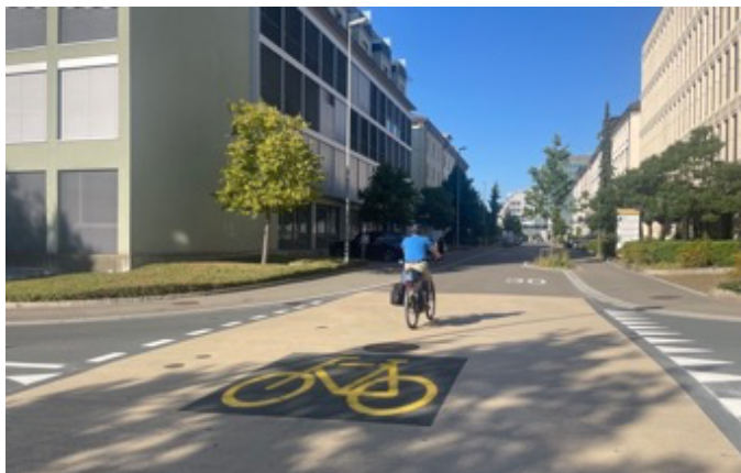
Abb.: Velostrasse Vadianstrasse St. Gallen (2022)
