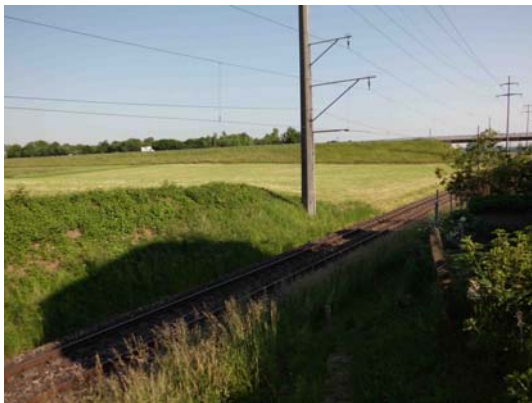
Bahnlinie SBB, Autobahnböschung
