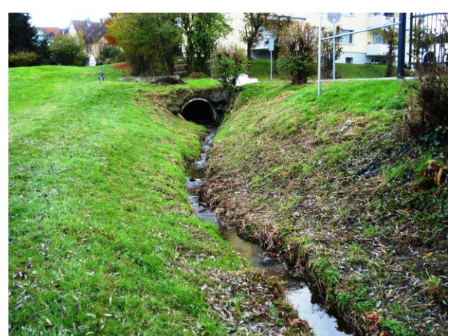
Foto 9; Durchlass Baumattstrasse, Auslauf
