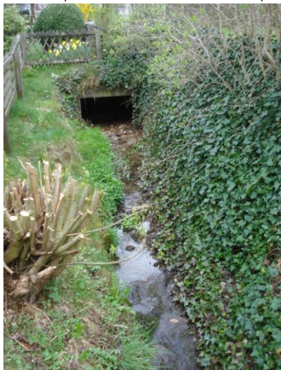
Foto 18; Durchlass Bischofszellerstrasse, Auslauf
