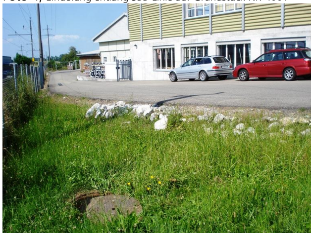
Foto 4; Eindolung entlang SBB-Linie auf Grundstück Nr. 4001
