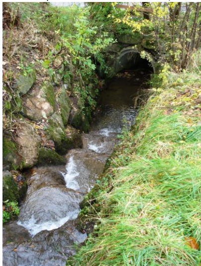
Foto 16; Durchlass Baumattstrasse, Einlauf
