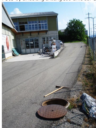
Foto 5; Eindolung entlang SBB-Linie auf Grundstück Nr. 4001
