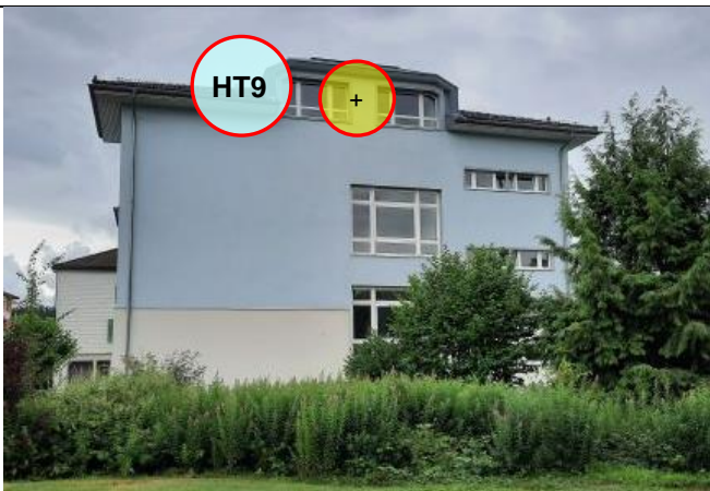
Bahnhofstrasse 11 (Schulhaus), Nord
