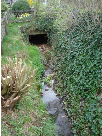
Foto 9; Durchlass Bischofszellerstrasse, Auslauf
