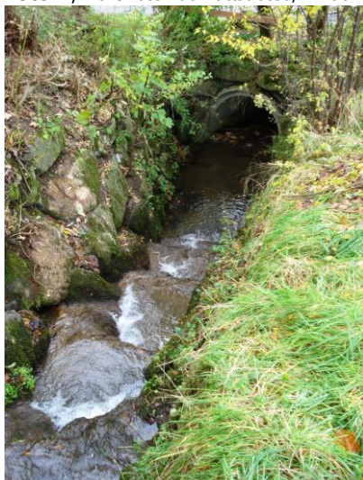
Foto 7; Durchlass Baumattstrasse, Einlauf
