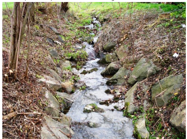
Foto 4; Sohlrampe vor Einlauf Eindolung SBB-Linie
