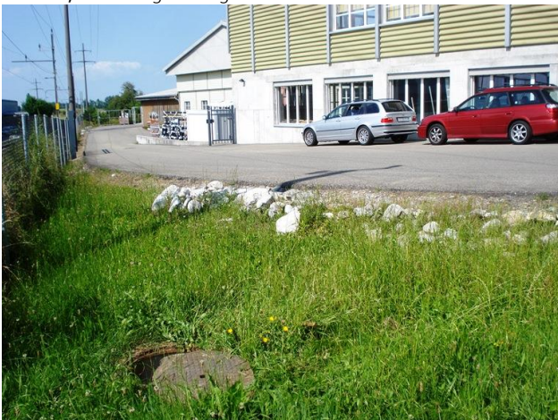
Foto 1; Eindolung entlang SBB-Linie auf Grundstück Nr. 4001
