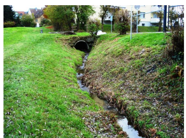
Foto 6; Durchlass Baumattstrasse, Auslauf
