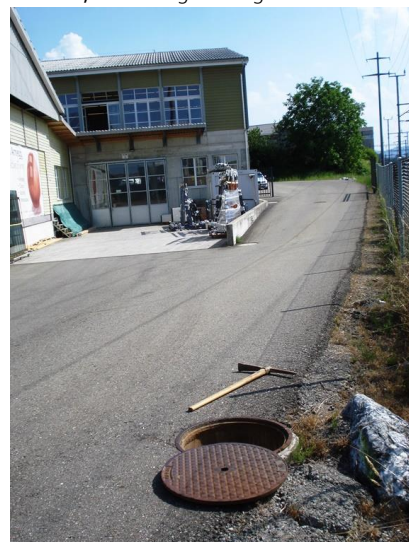
Foto 2; Eindolung entlang SBB-Linie auf Grundstück Nr. 4001
