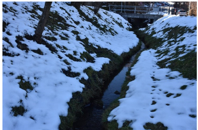
Foto 4: Gerinne zwischen Brücke Tiefgaragenzufahrt und Brücke Geissbergweg
