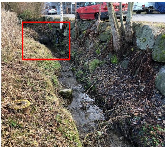
Abbildung 5: heute vorhandener Absturz bei m 87 (Foto: M+P)
