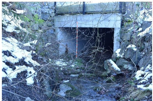
Foto 6: neuer Durchlass Seminarstrasse [2]
