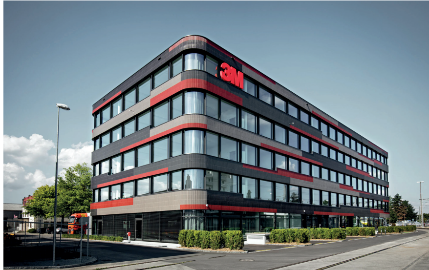
Abb. 8 Foto 3M-Gebäude, Marazzi + Paul Architekten Zürich / Bern
