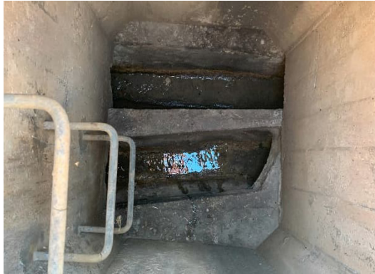
Abbildung 9: Doppelrohrsystem, Rinnen leicht ausgewaschen
