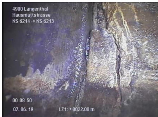
Abbildung 7: Muffe Scherbenbildung
