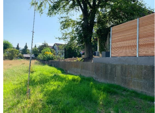
Abbildung 10: Grosser Baum über Schacht 6219
