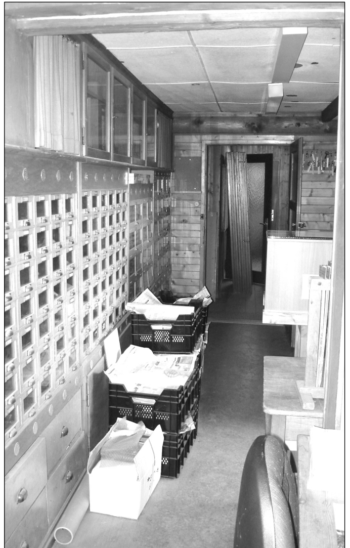
Brandschutztechnische Sanierung des Obergeschosses im Bürogebäude
