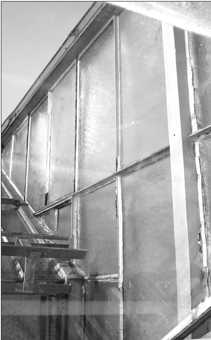
Sanierung der südlichen Aussenwand der Anzuchtgärtnerei
