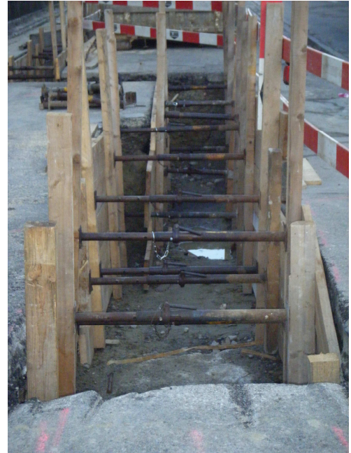
Offener Graben beim Fernleitungsbau in der Turnerstrasse (März 2010)
