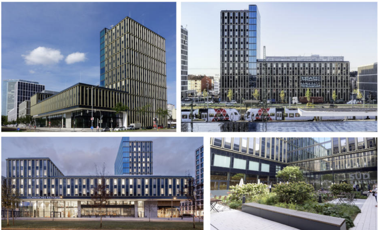
Abb. 23 Technisches Rathaus in Mannheim (Quelle: schneider + schumacher)
