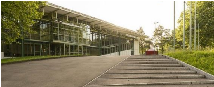
Parkgarage Kreuzbleiche Instandsetzung CHF -4.3 Mio.
