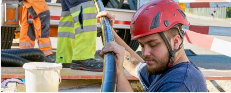
Darlehen sgsw Energieversorgung CHF 34.0 Mio.
