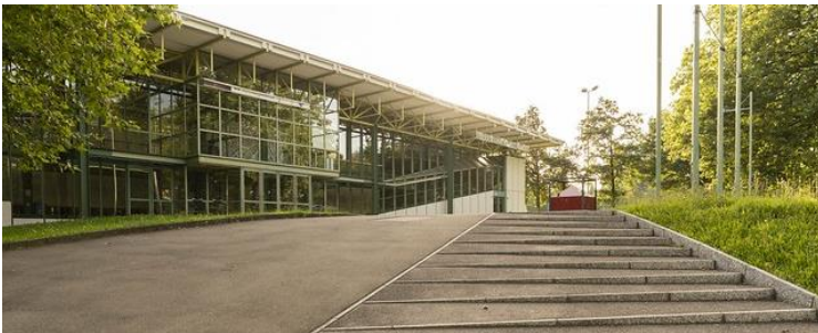
Parkgarage Kreuzbleiche Instandsetzung CHF 6.3 Mio.
