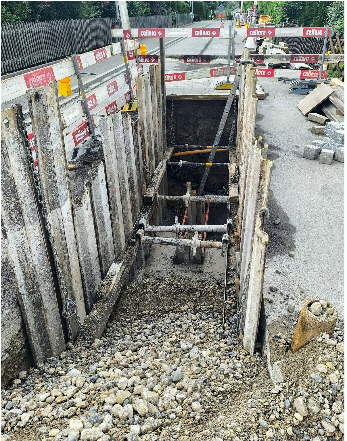
Als wichtiger Beitrag zum Gewässerschutz wurde an der Bruggwaldstrasse ein neuer Meteorwasserkanal erstellt zur getrennten Ableitung von sauberem Regenwasser und verschmutztem Abwasser. (Foto: Entsorgung St.Gallen)
