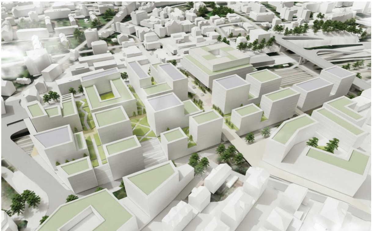
Abbildung 18: Visualisierung Überdeckung St.Fiden (Blick von Nord-Osten) (Quelle: KCAP)
