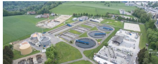
ARA Hofen Schlammmentwässerung
